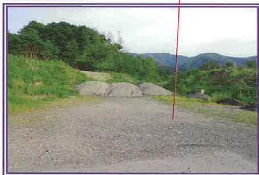
物件4の土地上に、砂利等が盛られている状況等を撮影したもの
