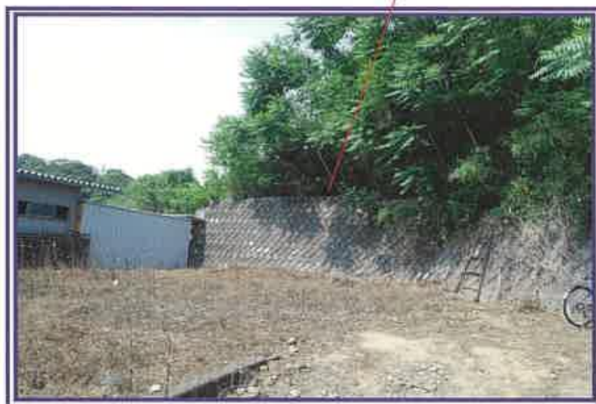
物件2の土地と、その南側隣地(地番3924番1)との間に、擁壁が存在する状況等を撮影したもの
