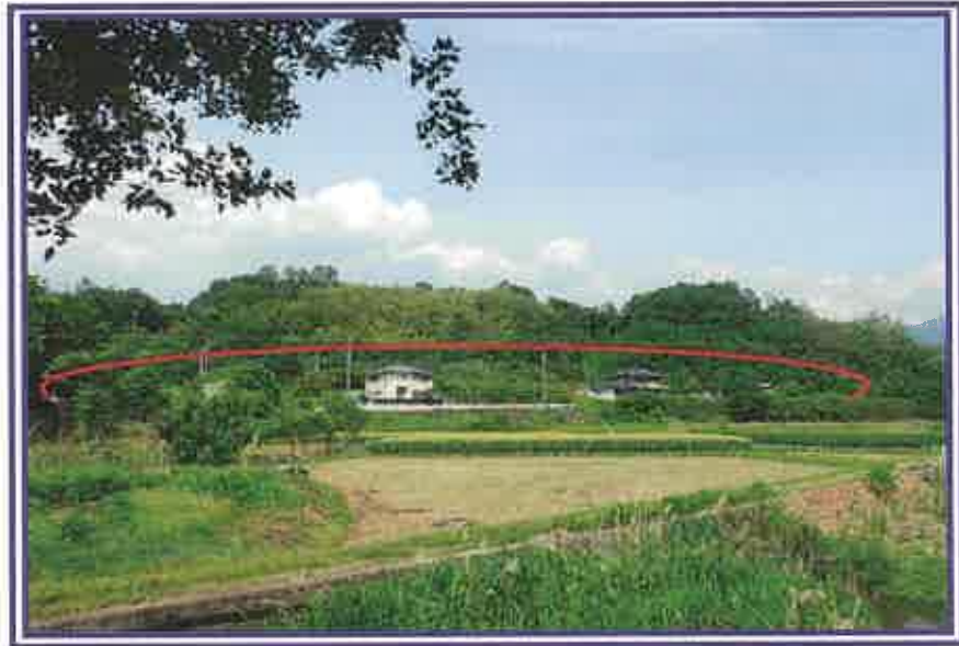
本物件の全景を撮影したもの
