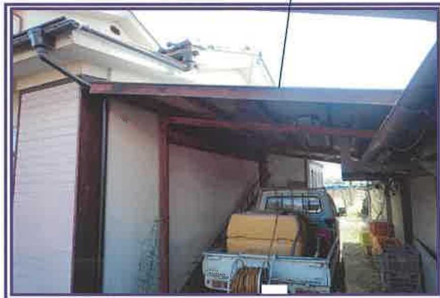
物件3(居宅)の西側に設置されている下屋付近を撮影したもの
