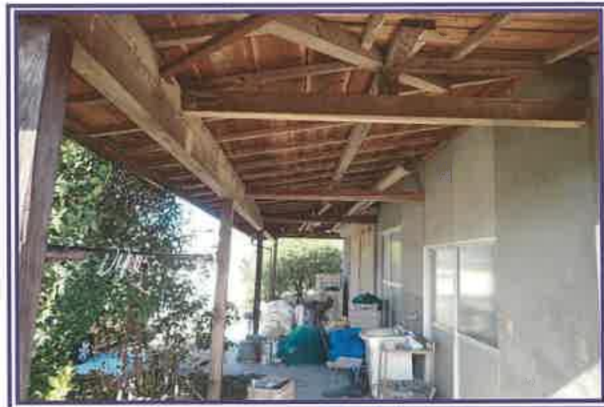
倉庫(未登記附属建物)の下屋付近を撮影したもの
