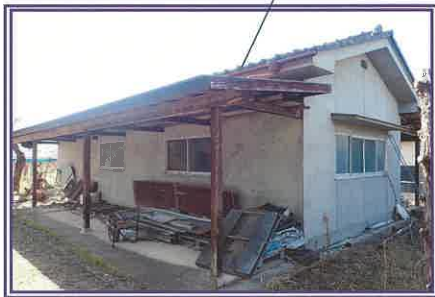
倉庫(未登記附属建物)
