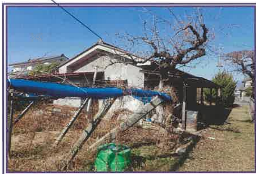
倉庫(未登記附属建物)
