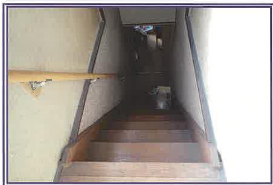
2階から、階段方向を撮影したもの(物件3主である建物)
