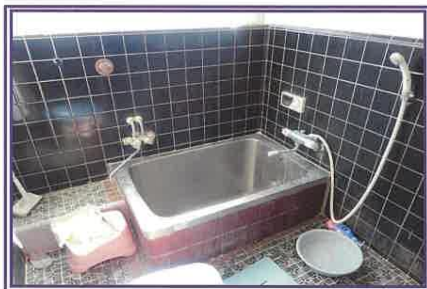
浴室 (物件3主である建物)
