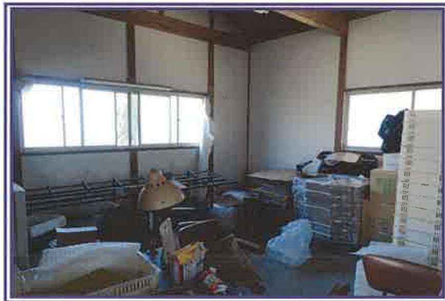
倉庫1(物件3未登記附属建物)
