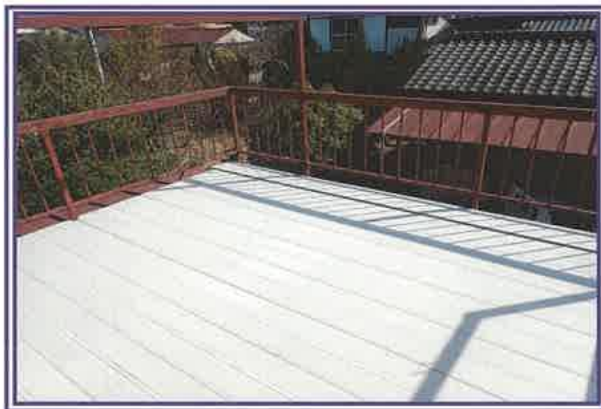
屋上 (物件3主である建物)
