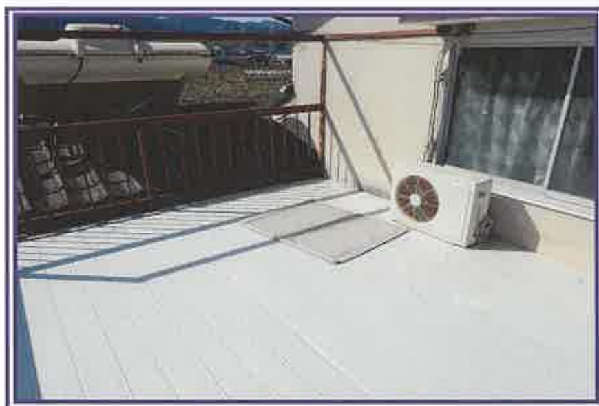
屋上 (物件3主である建物)
