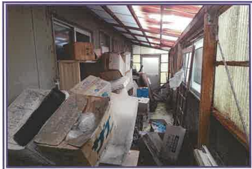
下屋内部を撮影したもの
