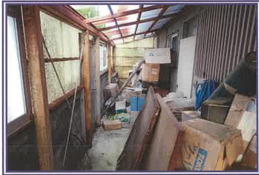
下屋内部を撮影したもの
