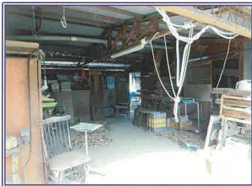
1階 作業室（物件3・附属建物2）
