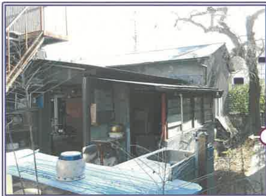
物件3・附属建物2（工場）の敷地内近景
