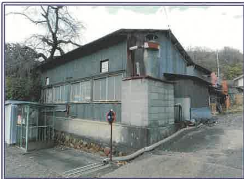
物件3・附属建物2（工棚）の県道側近景
