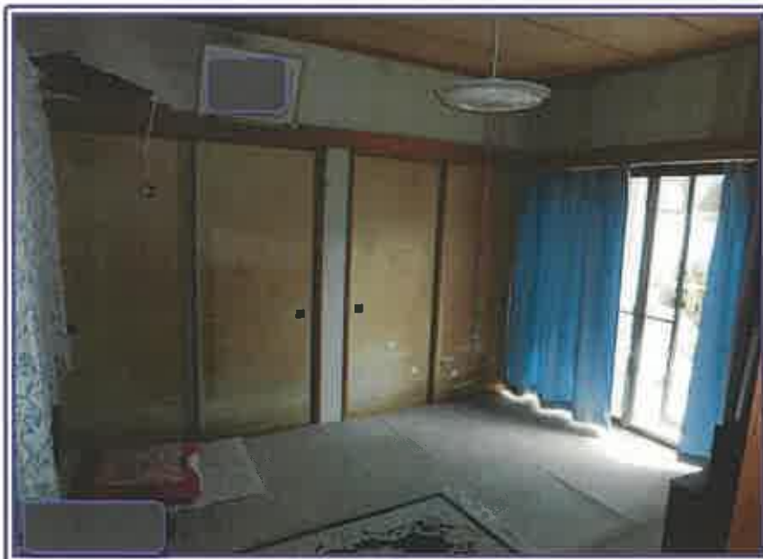
1階 和室（物件4・建物）
