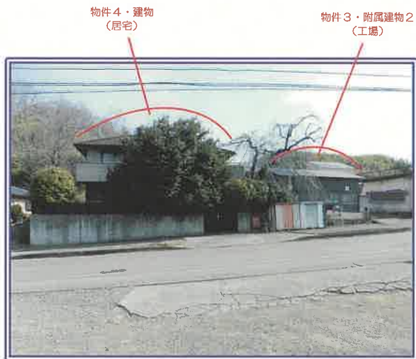
正面(県道)側全景
