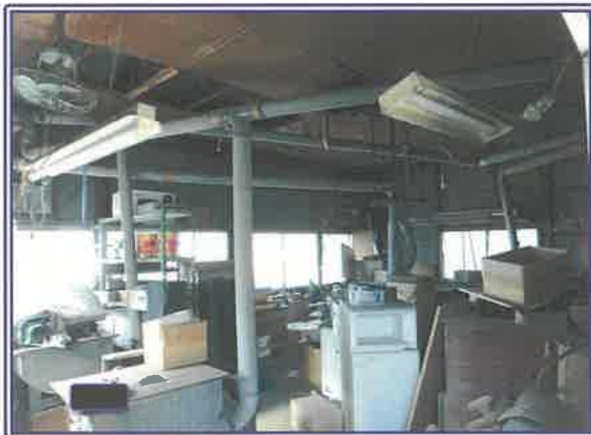
1階作業室（物件3・附属建物2）
