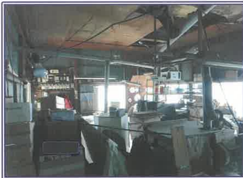
1階作業室（物件3・附属建物2）
