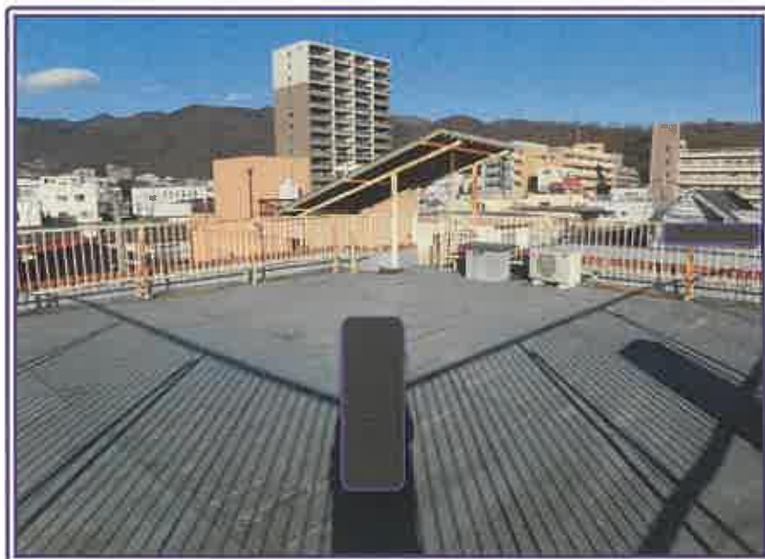
一棟の建物の屋上部分
