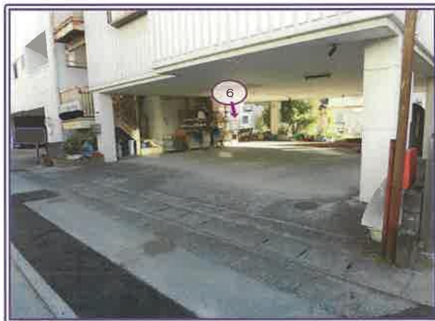
床下駐車場（表側）
