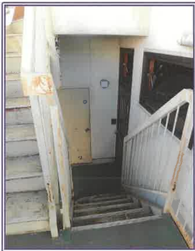
外階段と店舗・事務所・作業所（物件3）の玄関ポーチ（奥）
