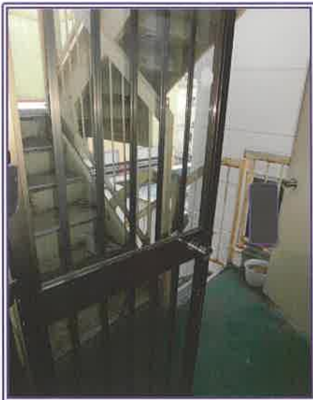
2階（物件3の■物）外階段・玄関ポーチ
