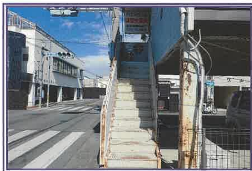
物件6(店舗)の外階段方向を撮影したもの
