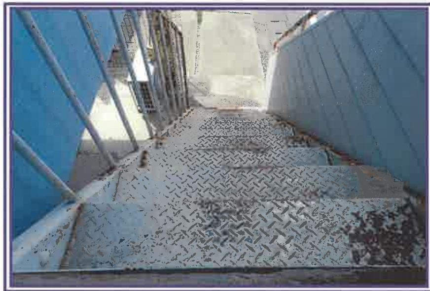
外階段方向を撮影したもの(物件6(店舗))
