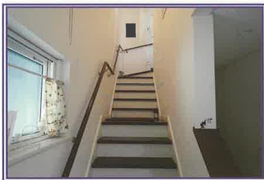
1階から、階段方向を撮影したもの(物件5(居宅))
