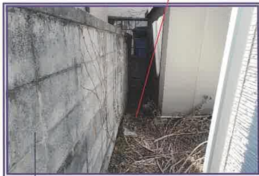
東側隣地(地番813番)との境界付近に設置されているブロック塀
