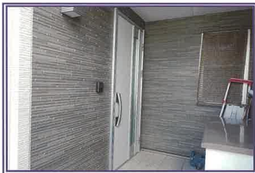
エントランス付近を撮影したもの(物件5(住宅))
