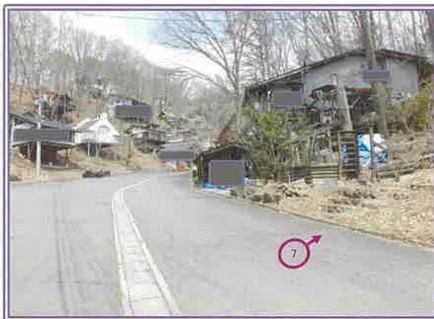
近傍広道の状況（左端の空地は駐車スペース）
