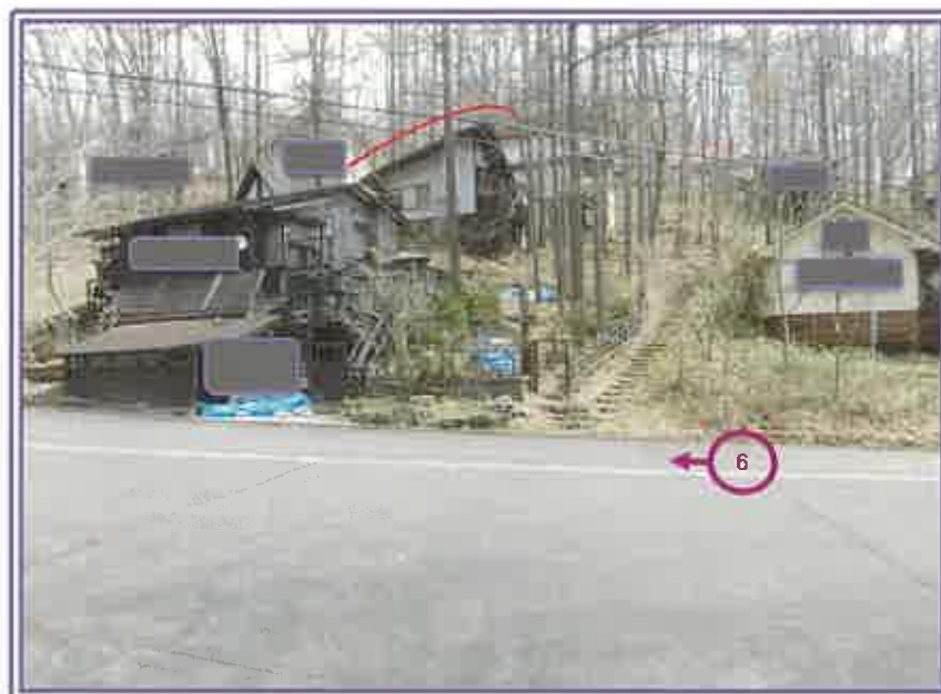
本件居宅の広道側遠景（手前の空地は駐車スペース）
