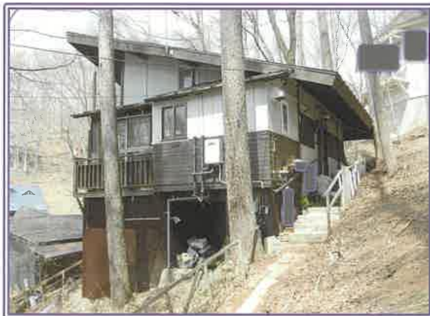
本件居宅の南側近景
