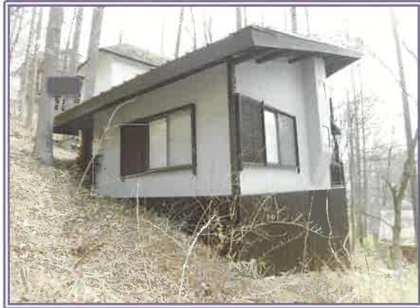
本件居宅の北西側近景
