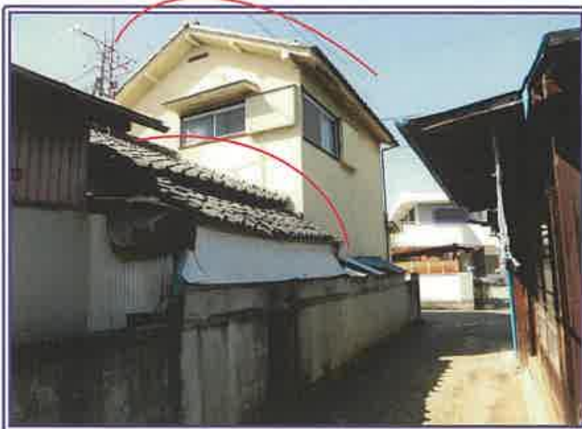
本件居宅の裏側近景 ※ 塀の左側が物件1の宅地・塀の右側は隣地（2048-3）
