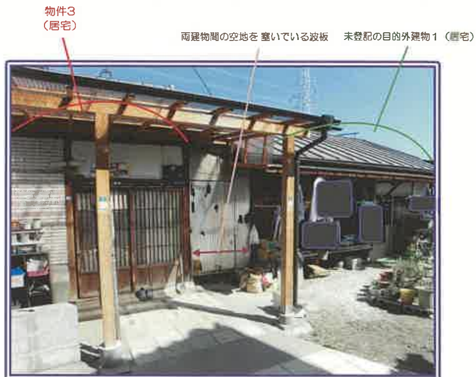
両建物の状況
