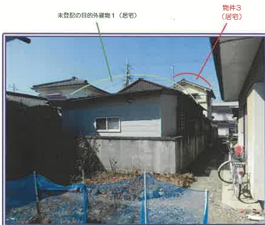
目的外建物1 (居宅) の裏側近景
