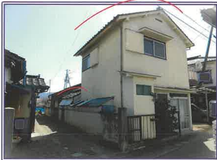
本件居宅の横側近景 ※ 居宅の底地の大方は 物件1の宅地
