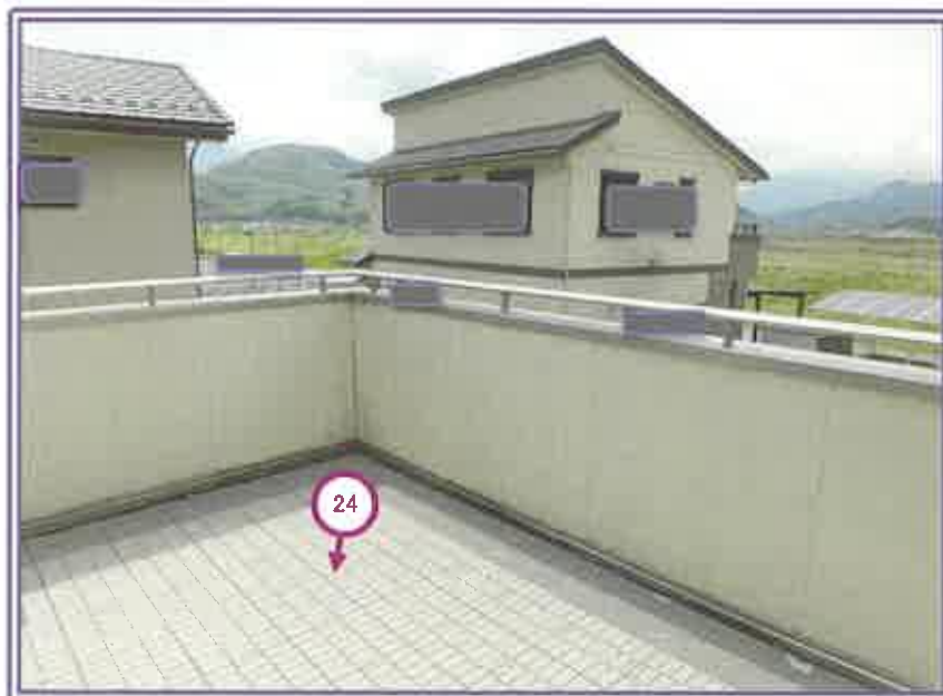
2階 バルコニー（外側）
