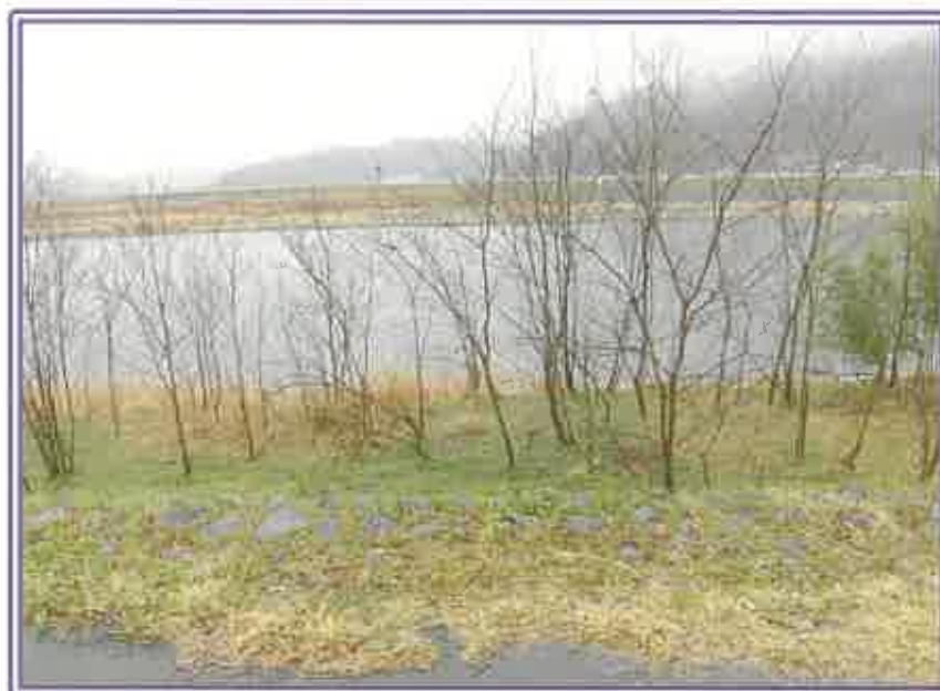
富士川の堤防敷の状況
