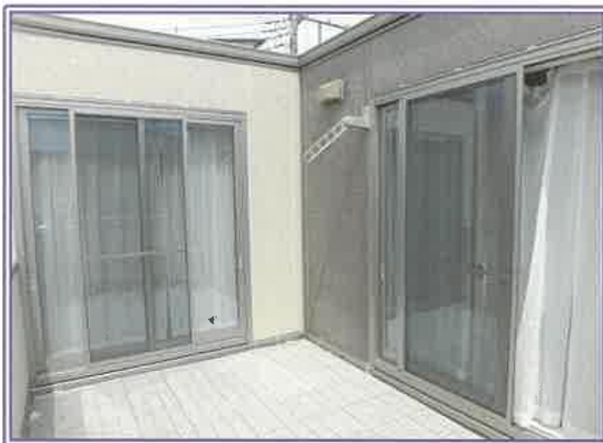
2階 バルコニー（窓側）
