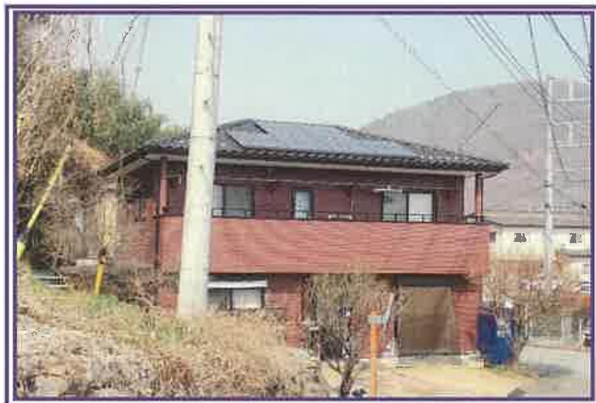
本件建物に設置されているソーラーパネルを撮影したもの(拡大撮影)
