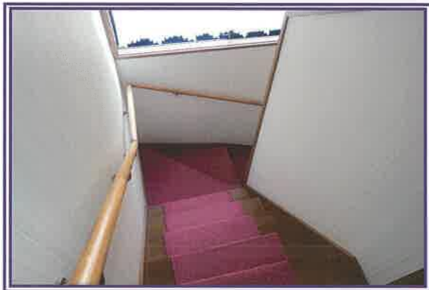
2階から、階段方向を撮影したもの
