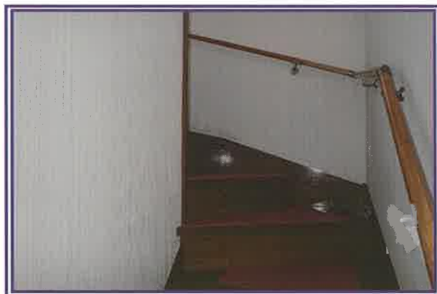
1階から、階段方向を撮影したもの
