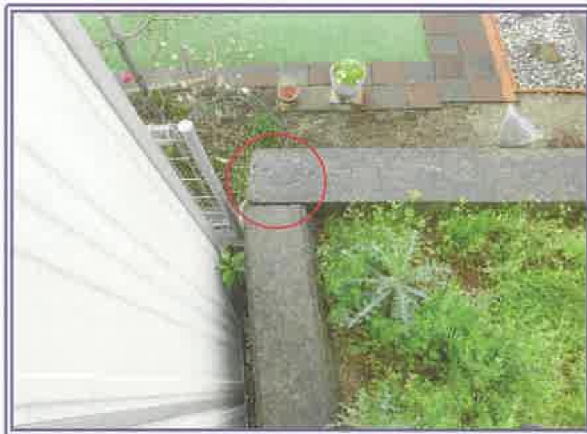
南角境界付近の状況
