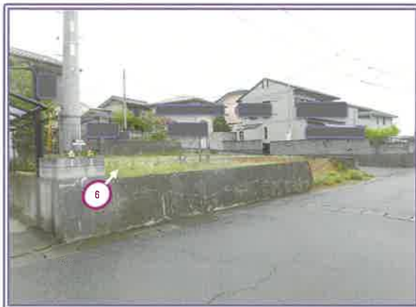
売却対象土地の市道側全景
