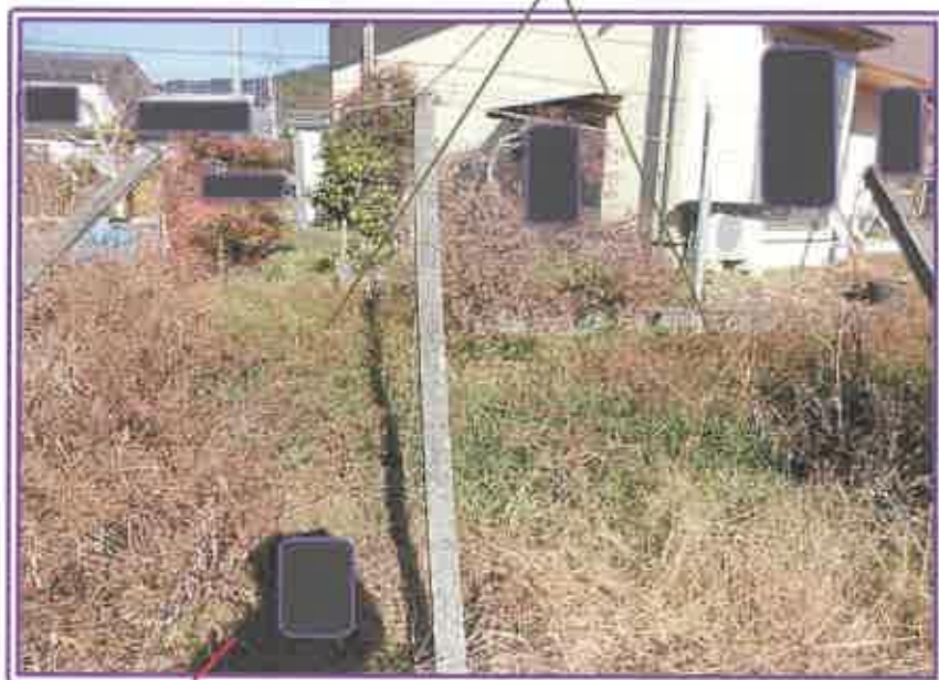
北東隅で接する公園上の道との接地状況
