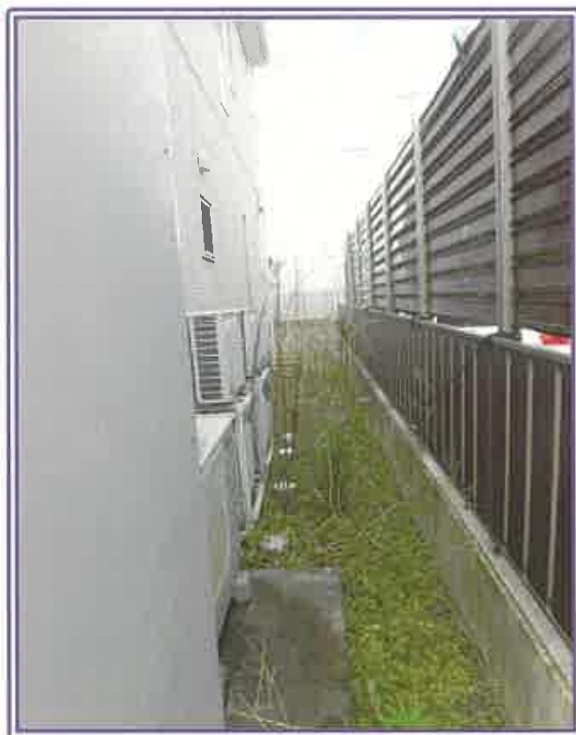
北側境界付近の状況
