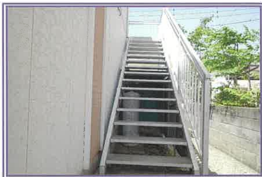
物件2(共同住宅)の、外階段(東側)方向を撮影したもの
