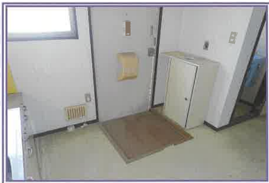
玄関付近を撮影したもの(101号室)
