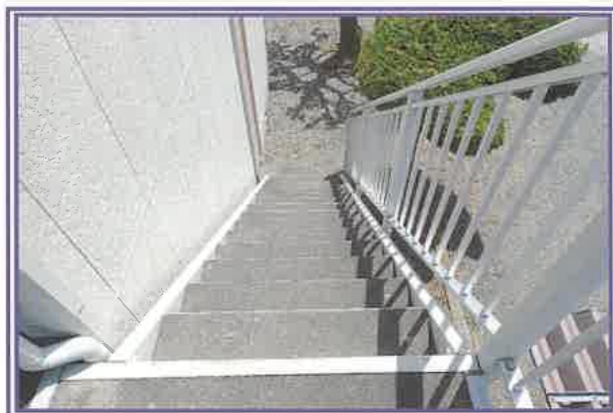
2階から、外階段(西側)方向を撮影したもの
