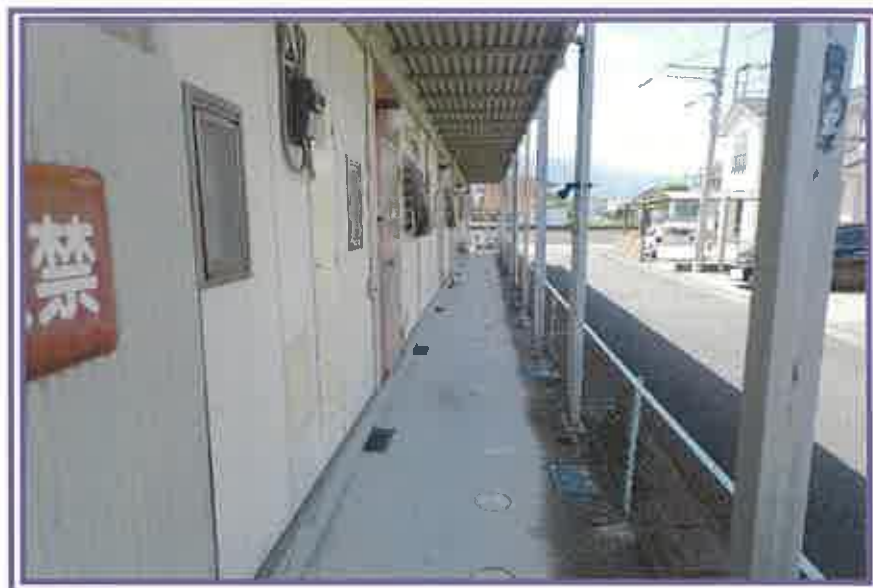
1階外通路付近を撮影したもの
