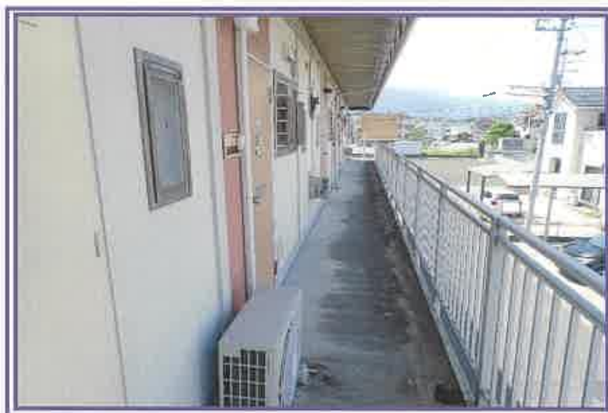
2階外通路付近を撮影したもの
