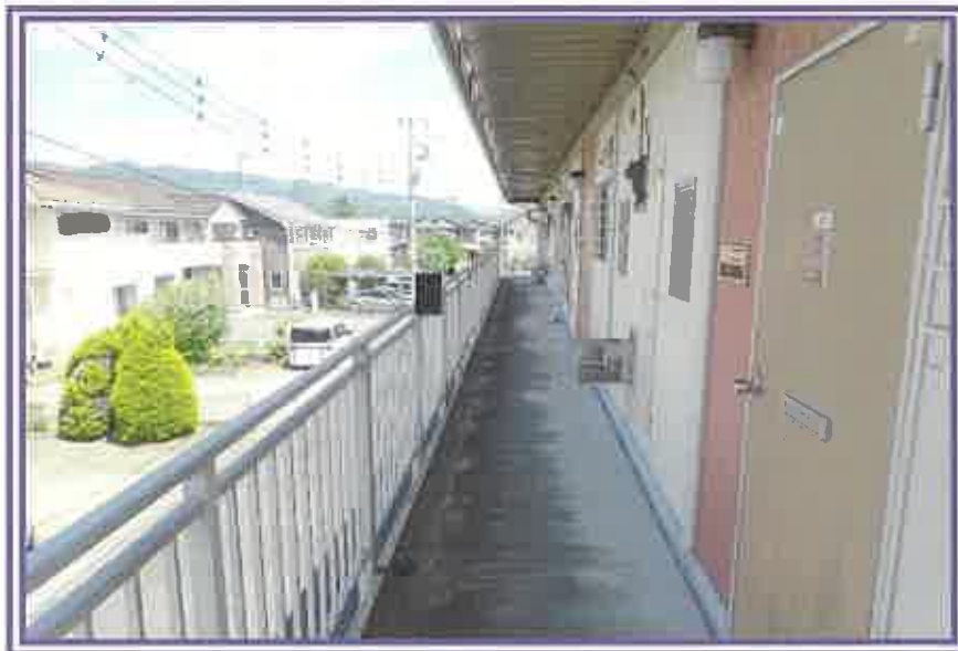
2階外通路付近を撮影したもの
