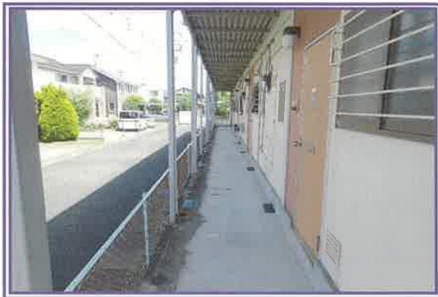
1階外通路付近を撮影したもの
