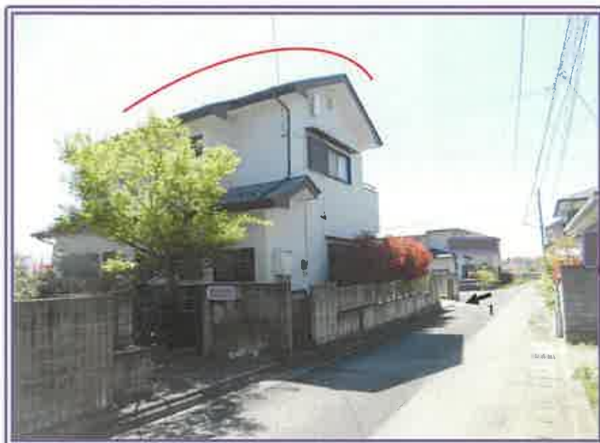
道路側の状況（左手前は隣宅の敷地（175-30））
