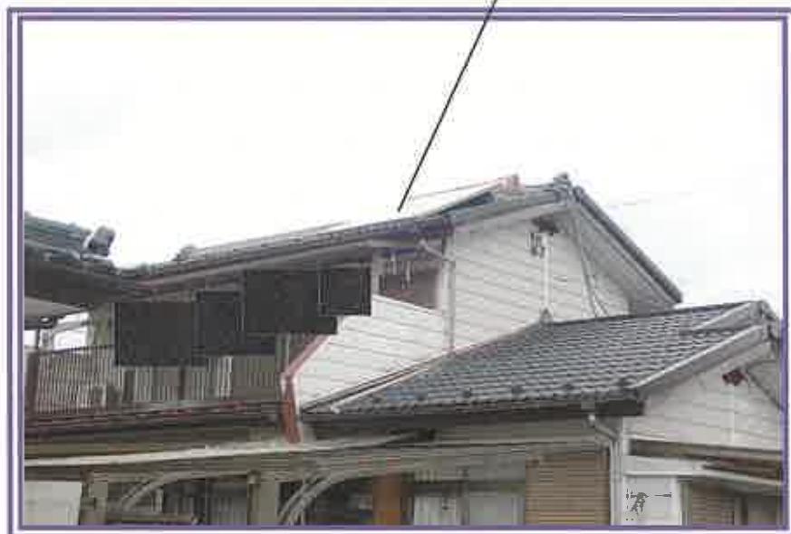
太陽光温水器及びその周辺を撮影したもの(拡大撮影)
