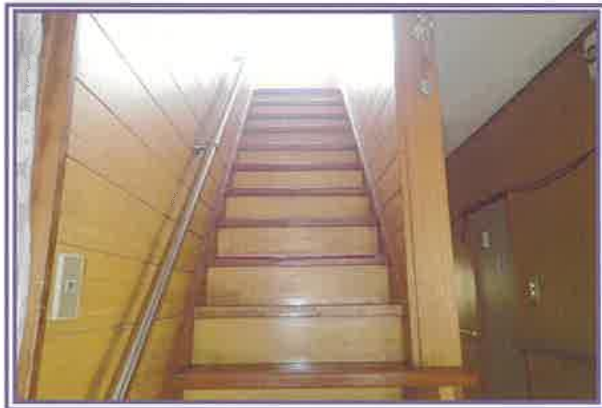
1階から、階段方向を撮影したもの
