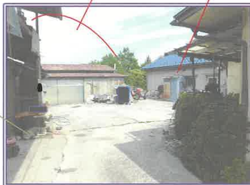
敷地（物件1の土地）内の状況
