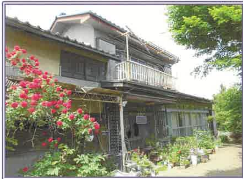
物件3の居宅の玄関前近景
