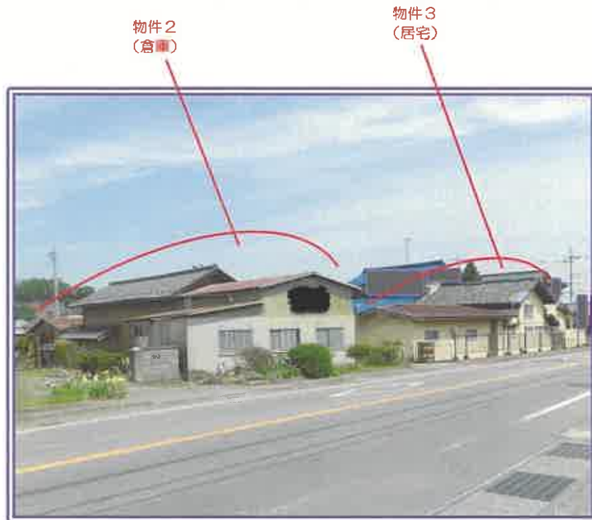
本件物件の全景（前面道路は国道141号線）
