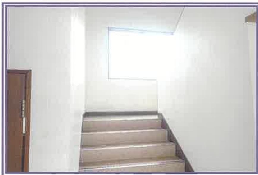
1階から、階段方向を撮影したもの
