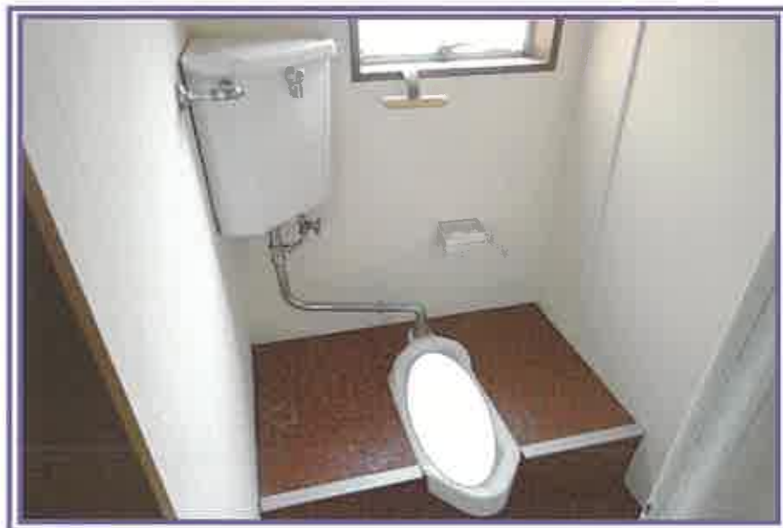
トイレ (事務室4内)
