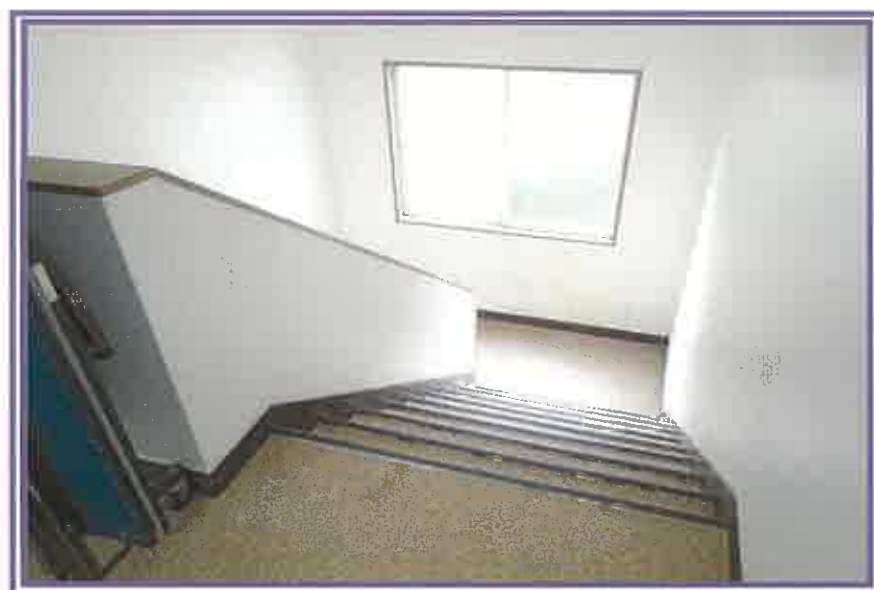
2階から、階段方向を撮影したもの
