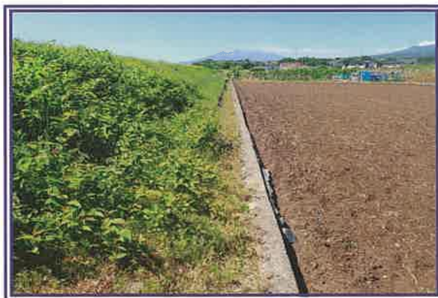
物件7, 8(雑種地)の各土地を含む一団の土地の西側に設置されている排水溝及びその周辺を撮影したもの
