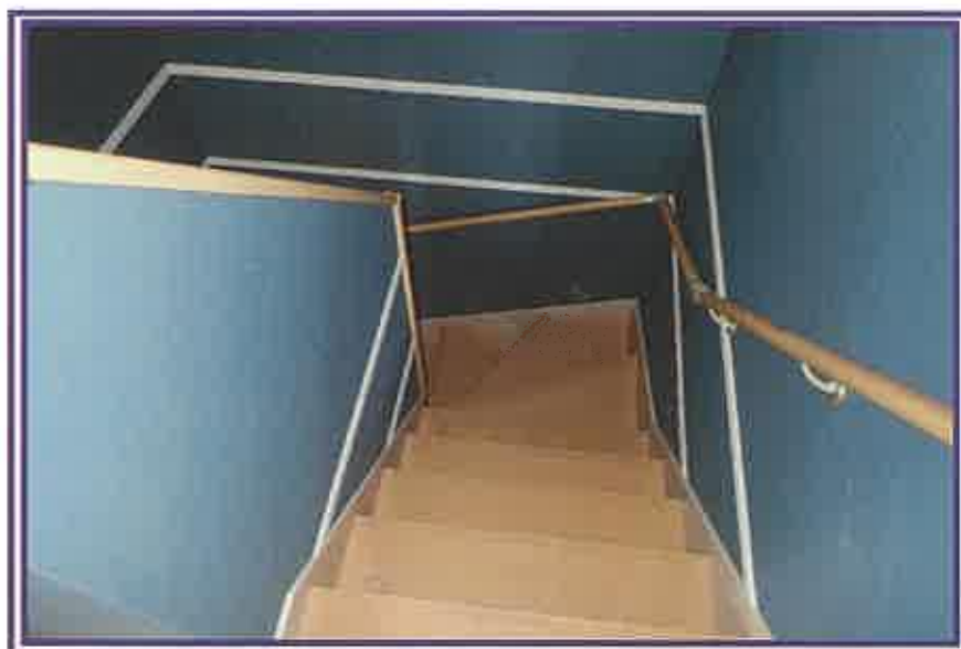
2階から、階段方向を撮影したもの
