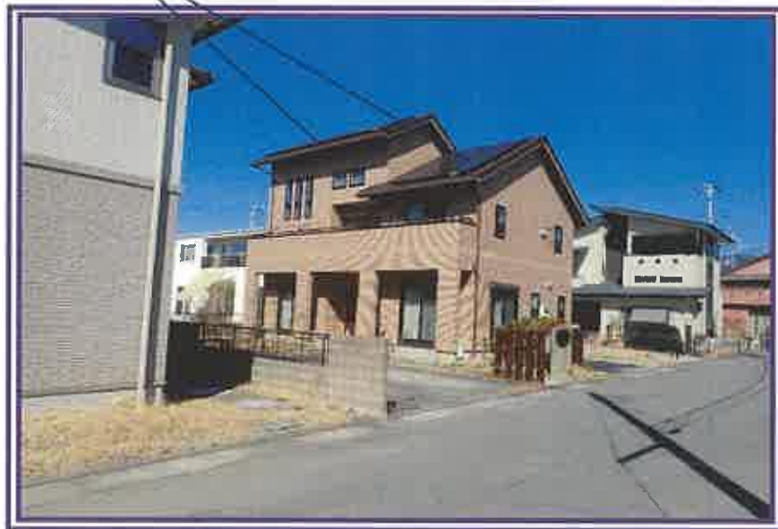
本件建物の屋根に設置されているソーラーパネルを撮影したもの
