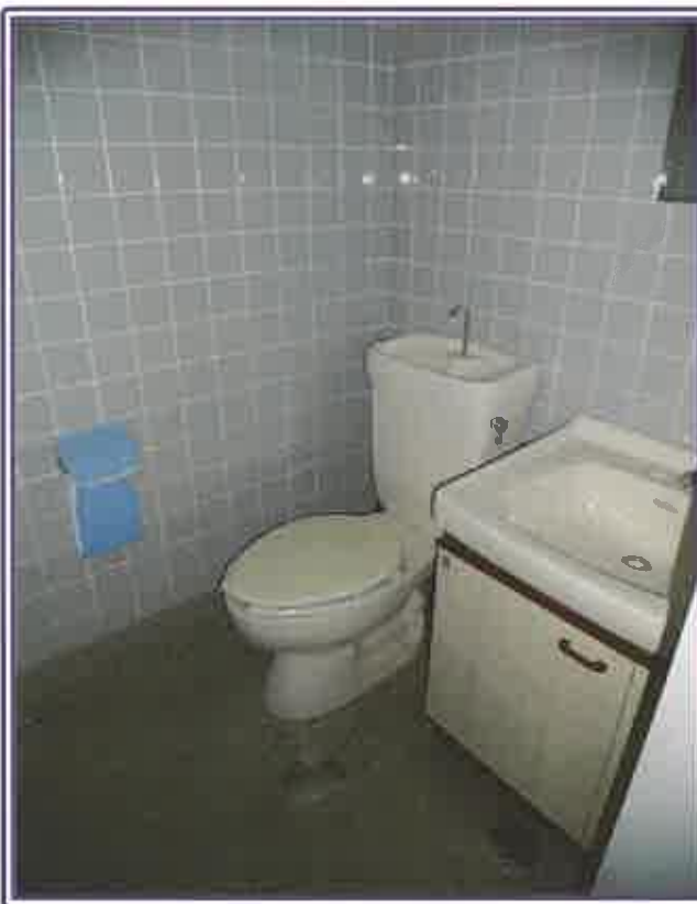
トイレ（306号室・物件1の区分所有建物）
