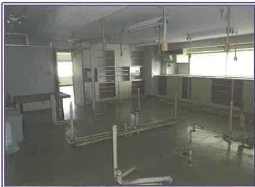
実習室（306号室・物件1の区分所有建物）
