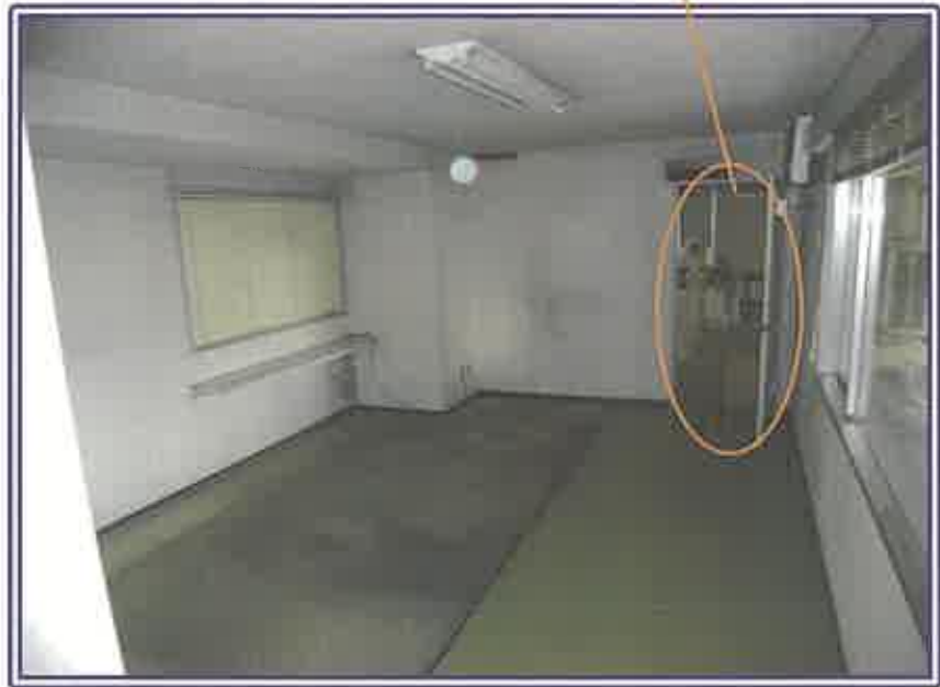
事務室（307号室・物件1の区分所有建物）
