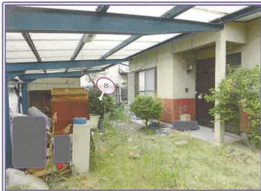
敷地内の状況
