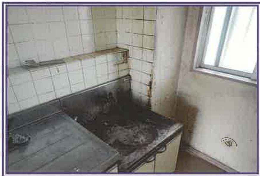
コンロ回りを撮影したもの(台所。101号室)
