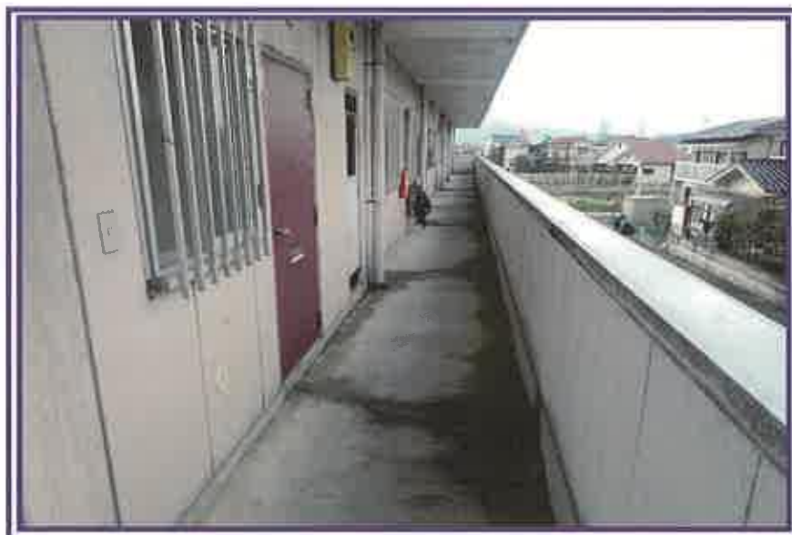
2階外廊下を撮影したもの
