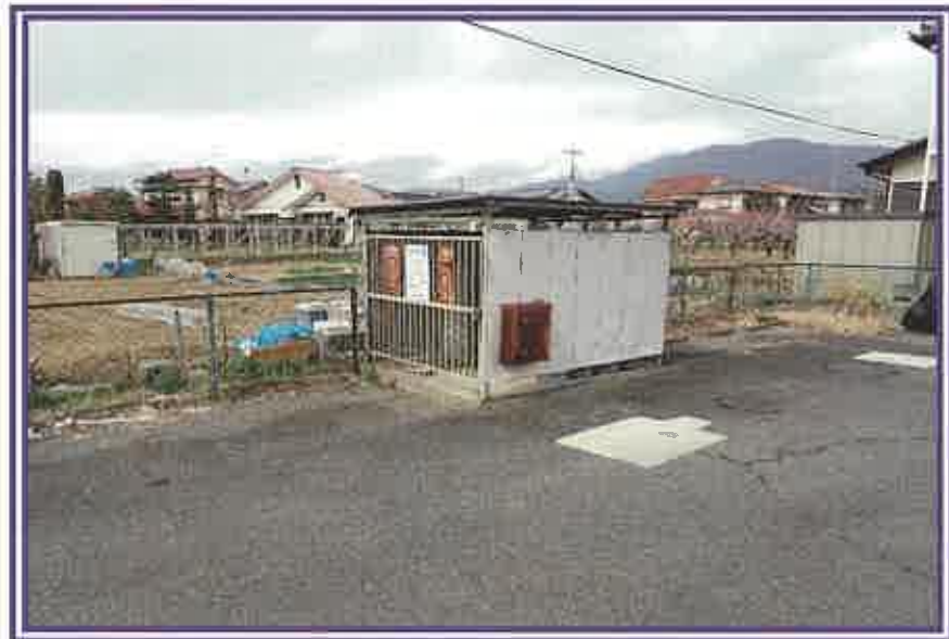
LPガス容器置場及びその周辺を撮影したもの
