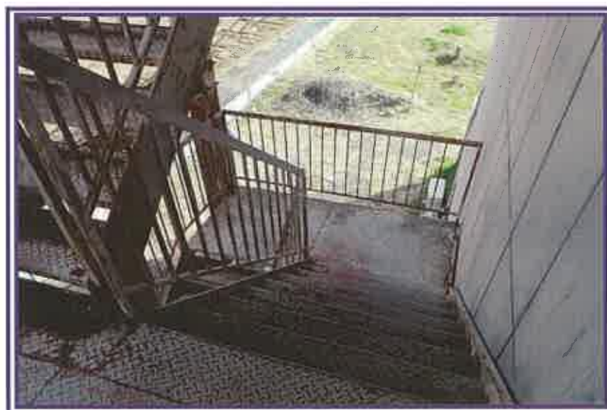
2階から、東側階段(外階段)方向を撮影したもの
