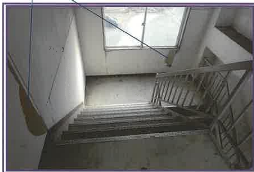
3階から、西側階段(屋内)方向を撮影したもの
