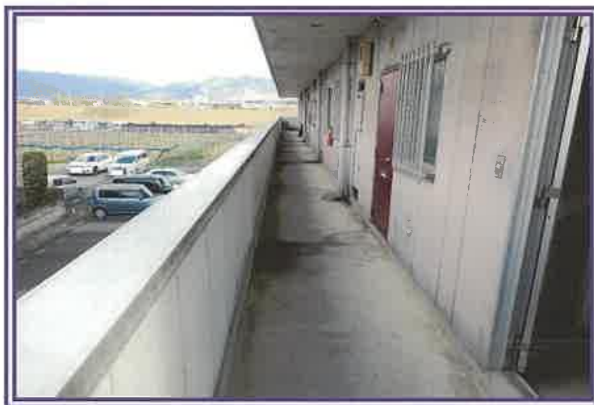
2階外廊下を撮影したもの
