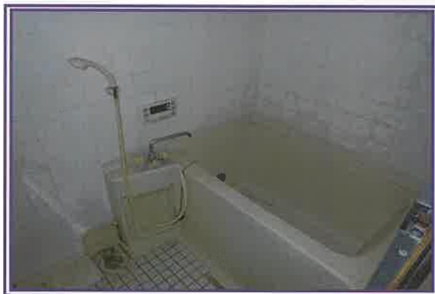
ユニットバス(101号室)
