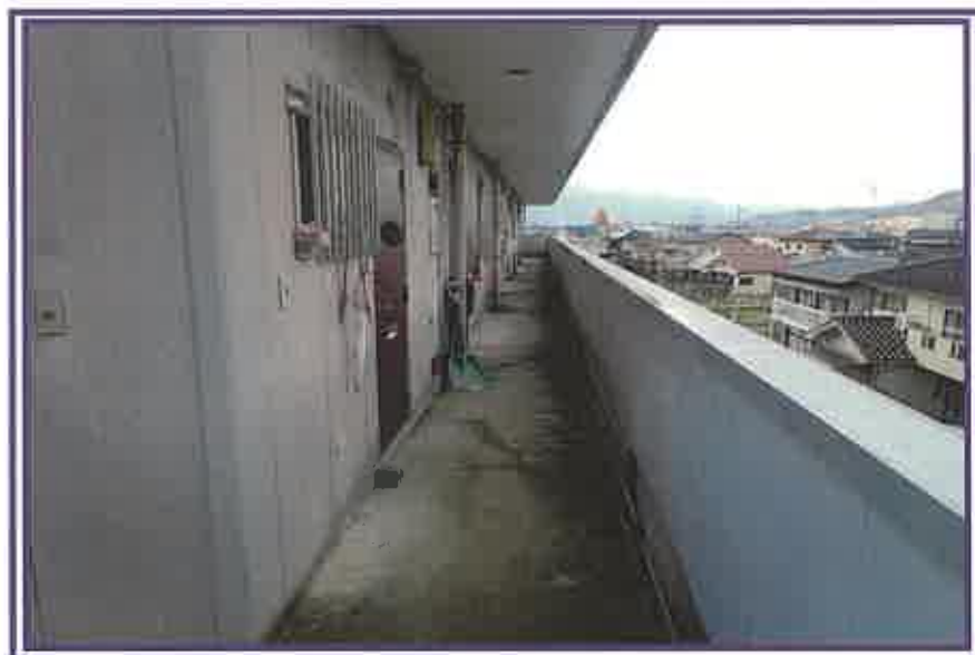
3階外廊下を撮影したもの
