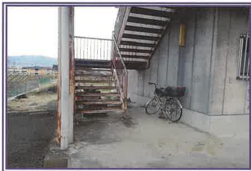
1階から、東側階段(外階段)方向を撮影したもの
