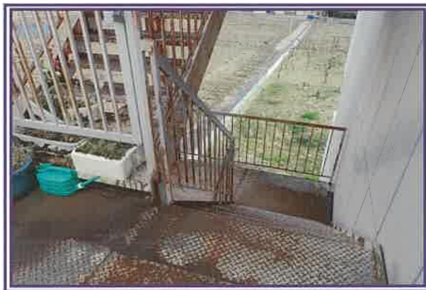
3階から、東側階段(外階段)方向を撮影したもの
