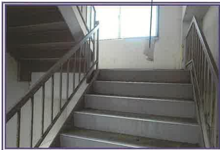
2階から、西側階段(屋内)方向を撮影したもの
