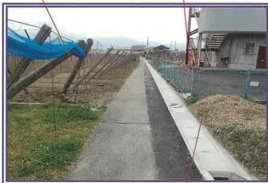
北側隣地 (1503-1)付近
