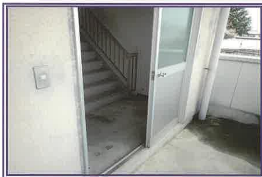
西側階段への入口付近を撮影したもの
