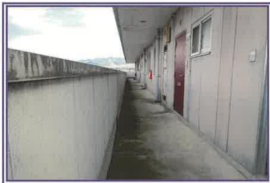
3階外廊下を撮影したもの
