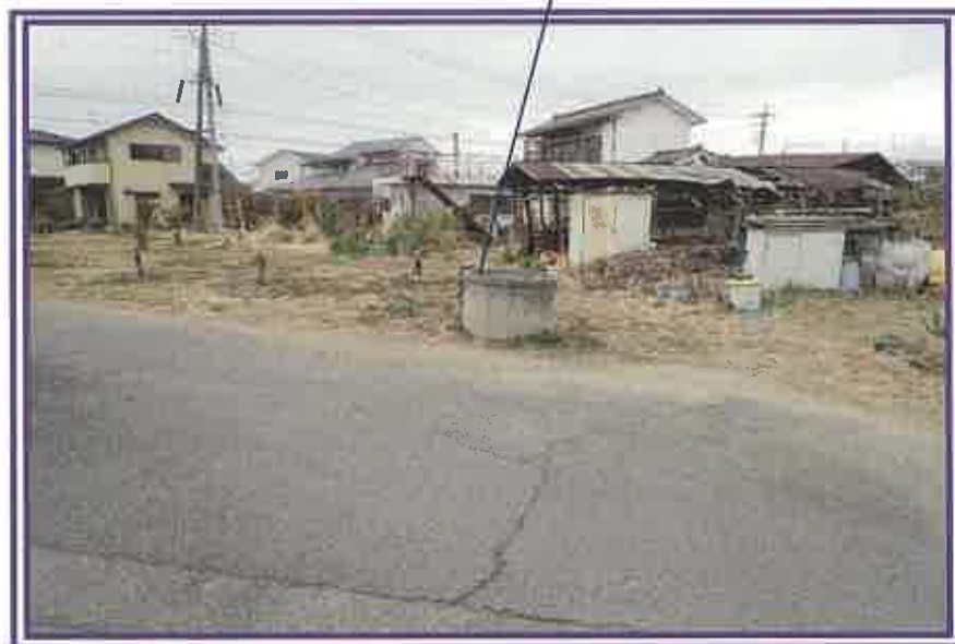
コンクリート製の工作物及びその周辺を撮影したもの
