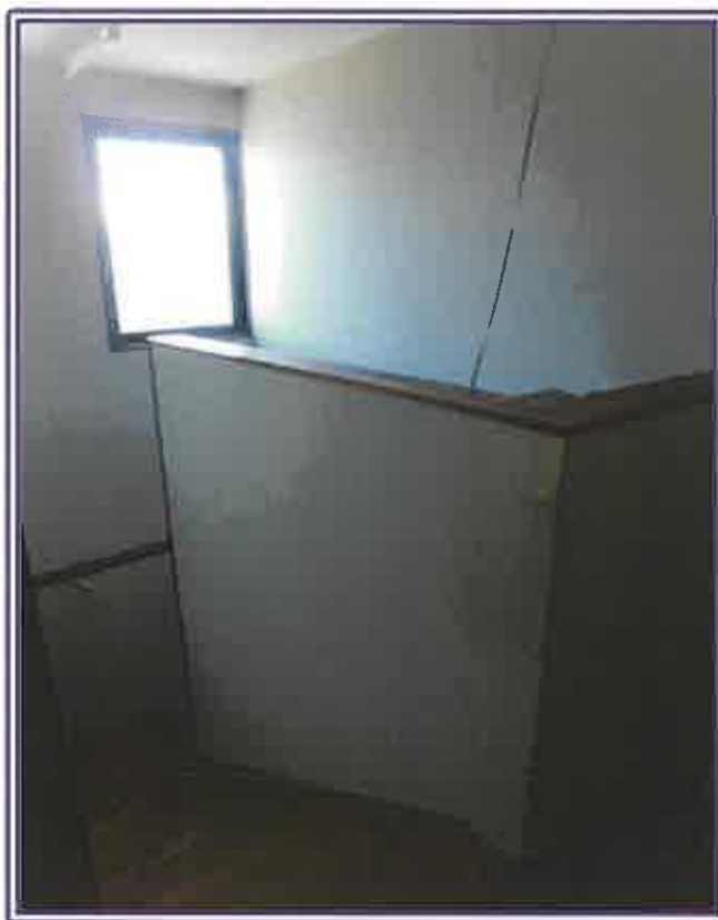
2階 階段（主たる建物）
