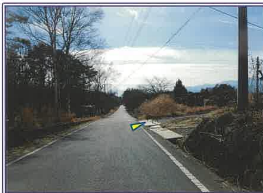
東側で隣接する公道の状況
