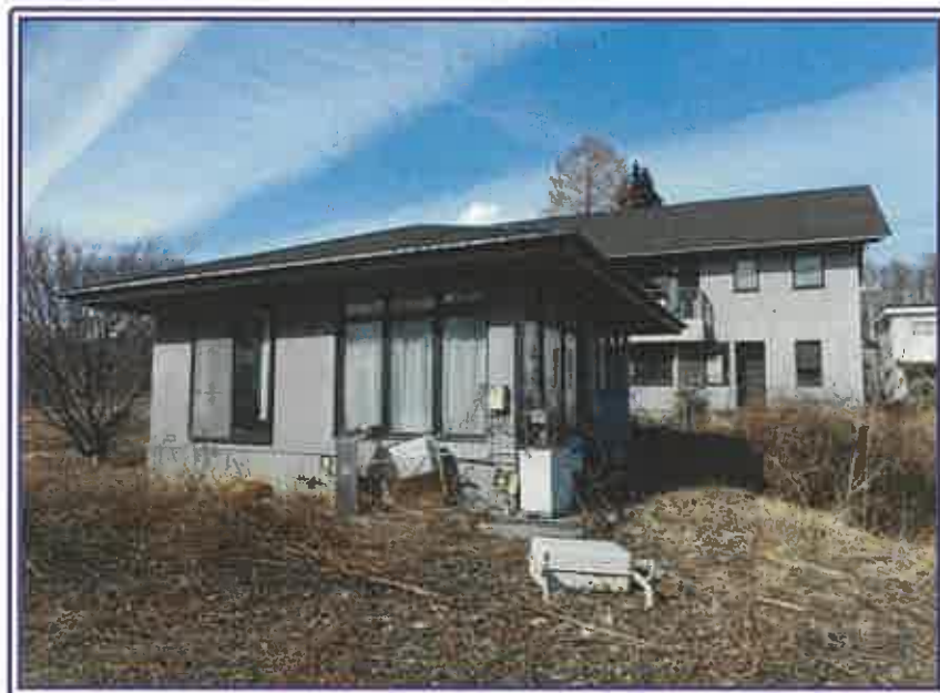
本件建物の南東側近景（手前が附属建物・奥が主たる建物）
