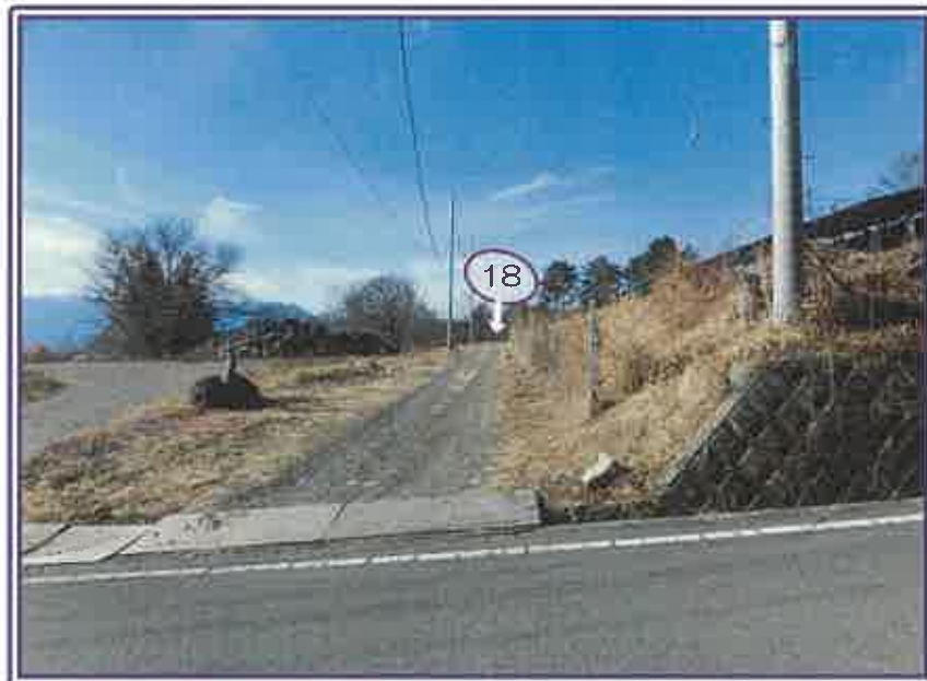
北側で隣接する砂利道の状況
