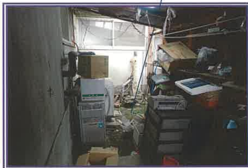
下屋内部を撮影したもの
