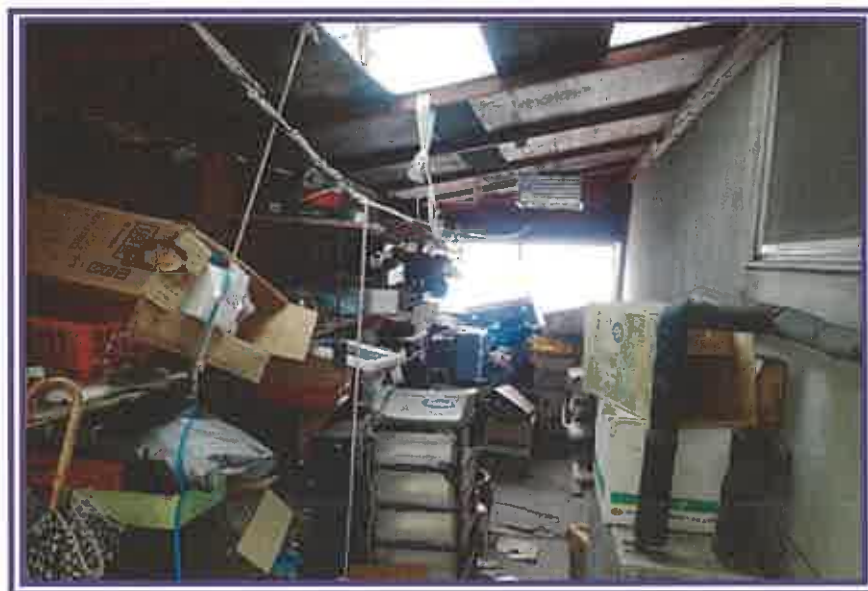
下屋内部を撮影したもの
