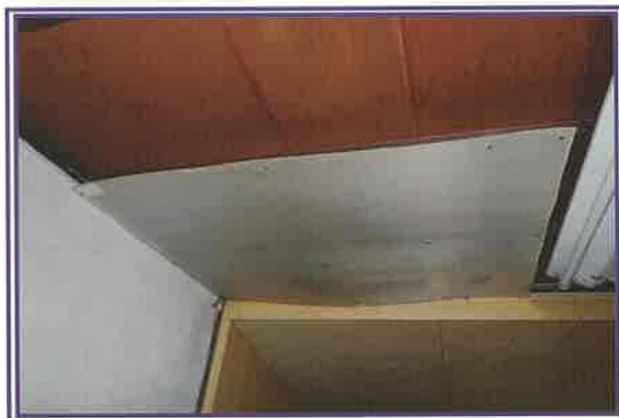
洋室1の天井に、プラスチック板が張られている状況を撮影したもの
