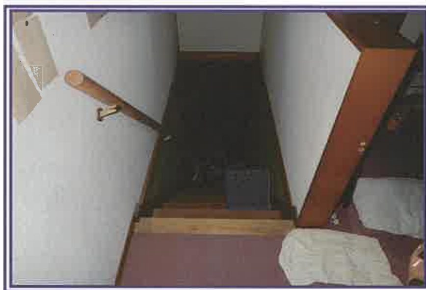
2階から、階段方向を撮影したもの
