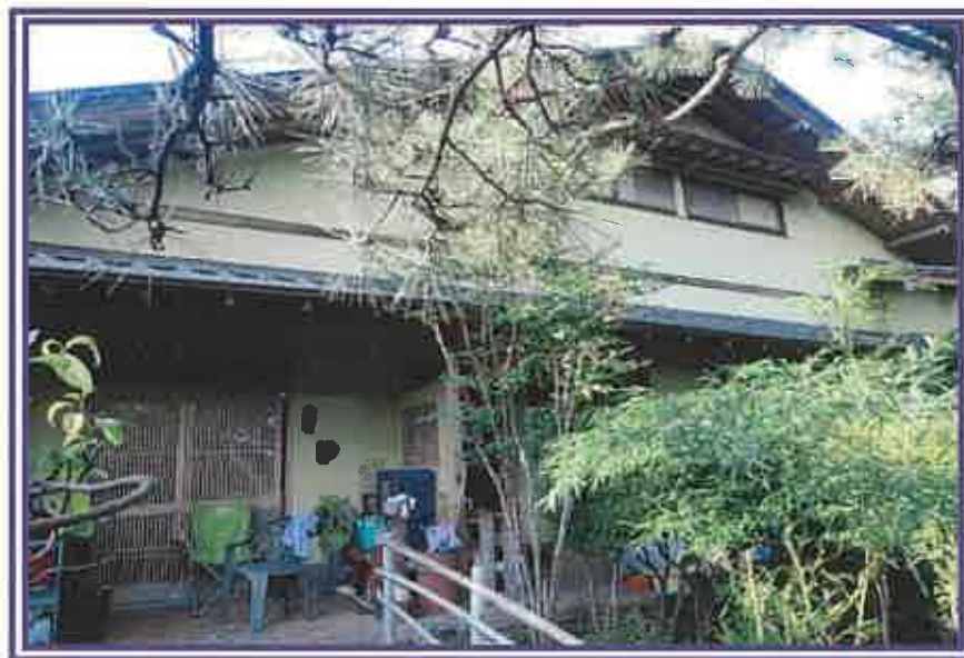
物件4(居宅)の玄関付近を撮影したもの
