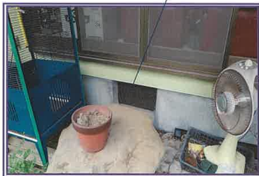
地下室の通気口及びその周辺を撮影したもの (ただし、広縁付近のもの)
