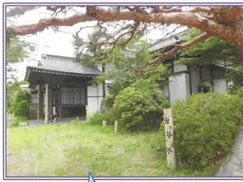
裏側出入口の状況
