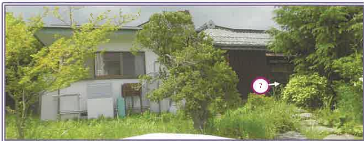
物件1の建物の駐車場側近景
