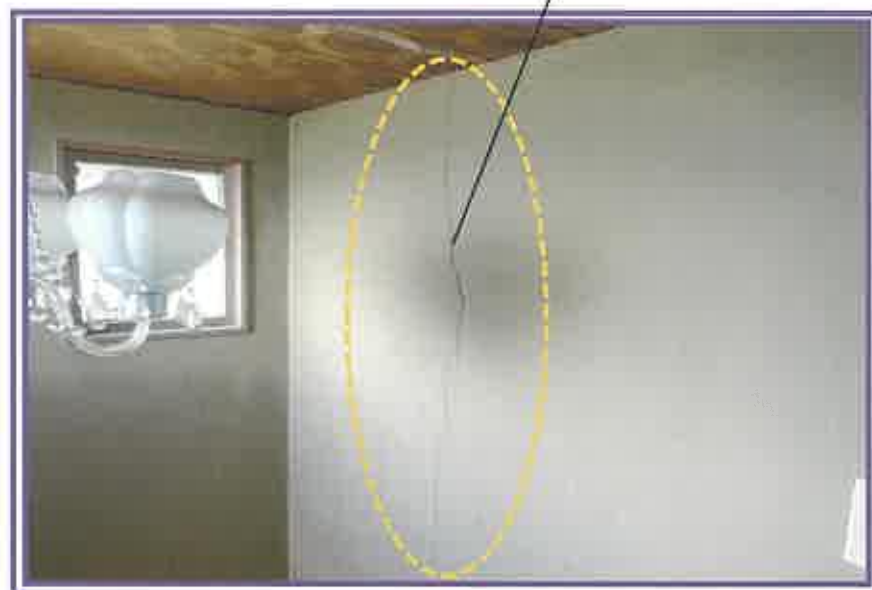
階段の壁に、亀裂が認められる状況を撮影したもの
