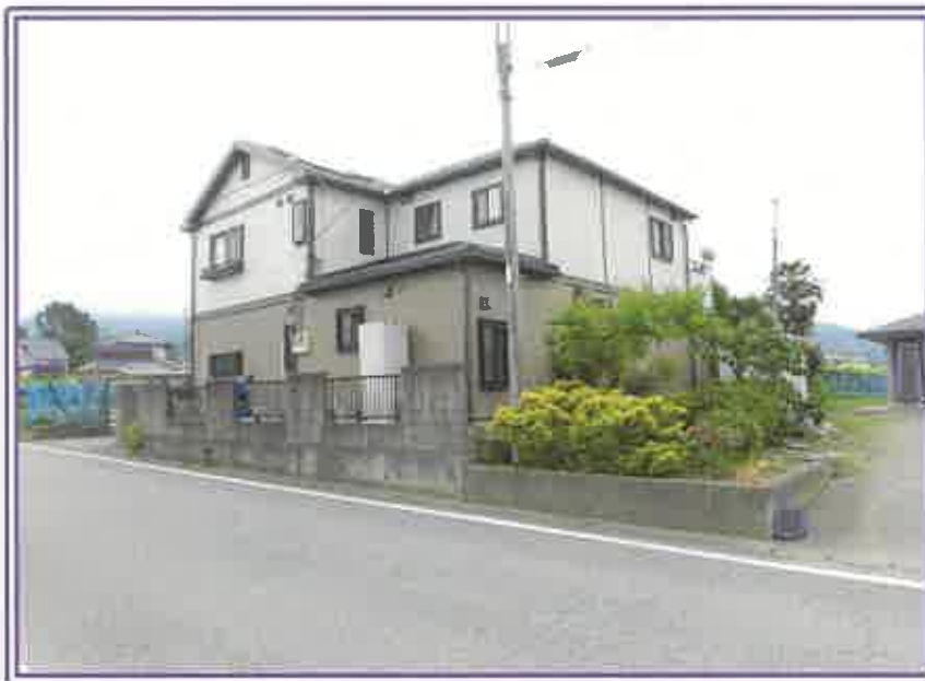
本件建物の県道側近景（電柱より右側は 隣地（203））
