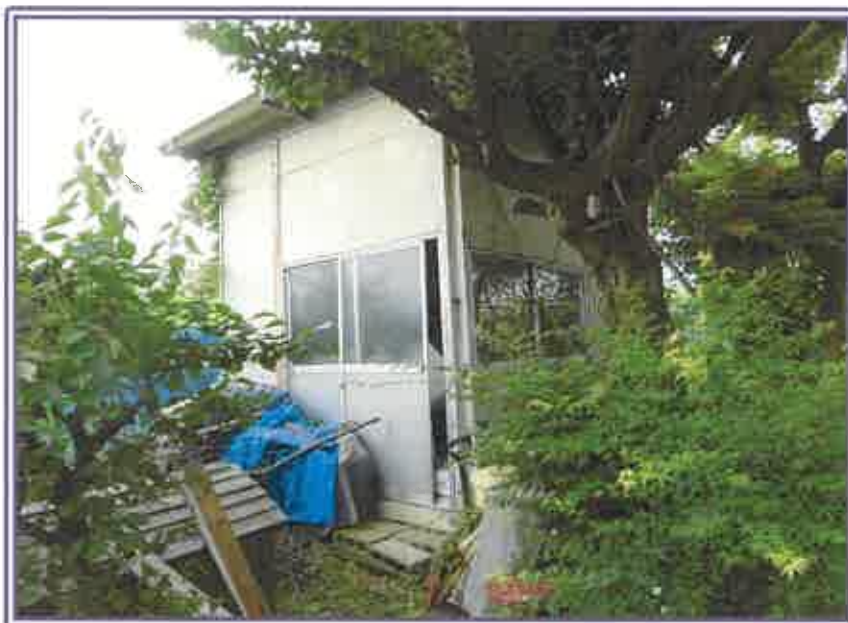
敷地内の仮設式物置（構築物）
