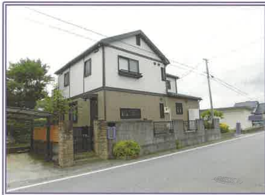
本件建物の県道側近景
