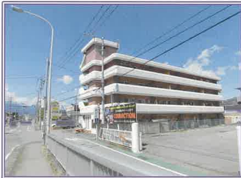
本件物件の横側全景
