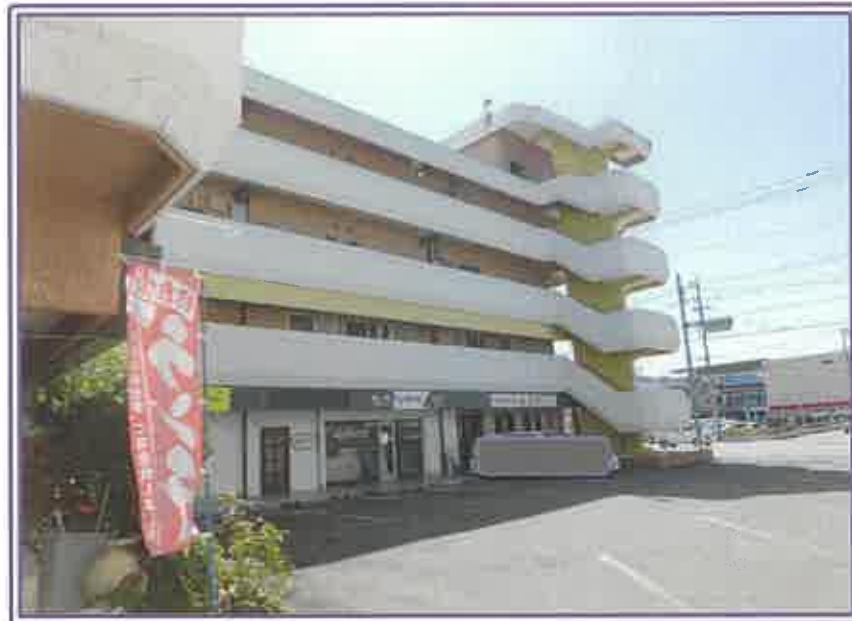
本件物件の正面側近景
