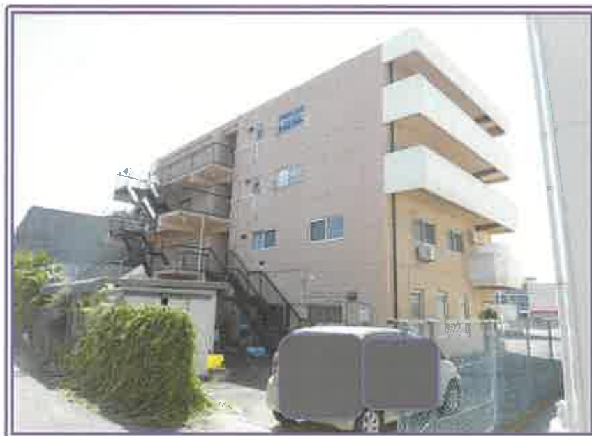
本件物件の後側全景
