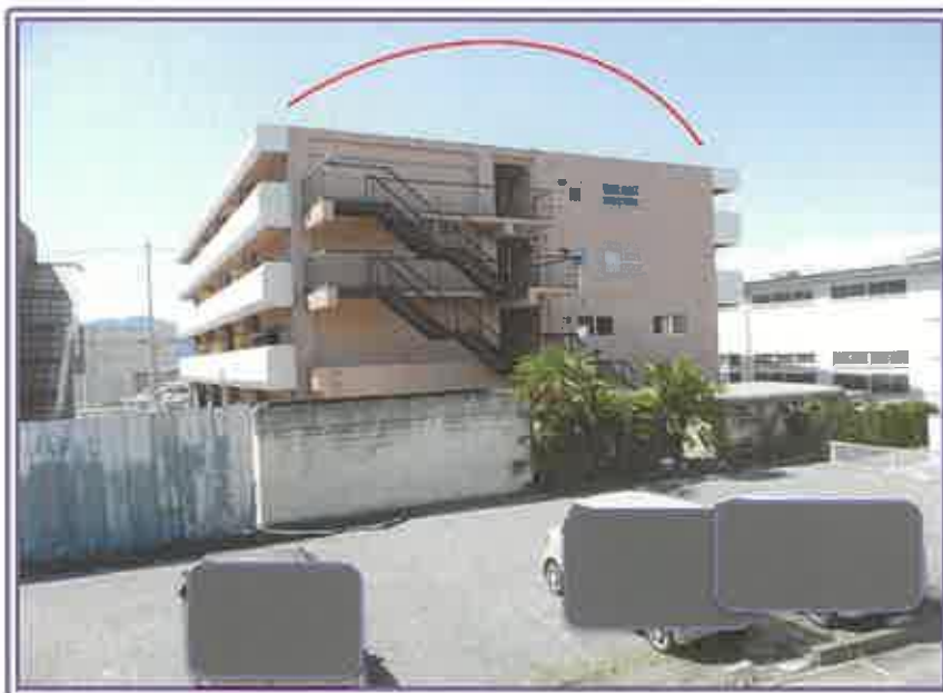
本件物件の後側遠景 ※ 手前は隣地（702）
