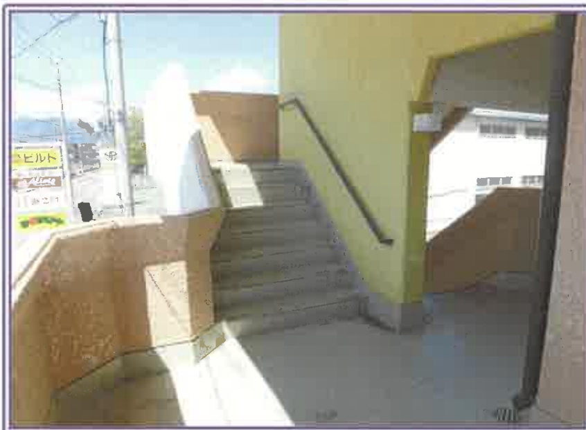
外階段（道路側）
