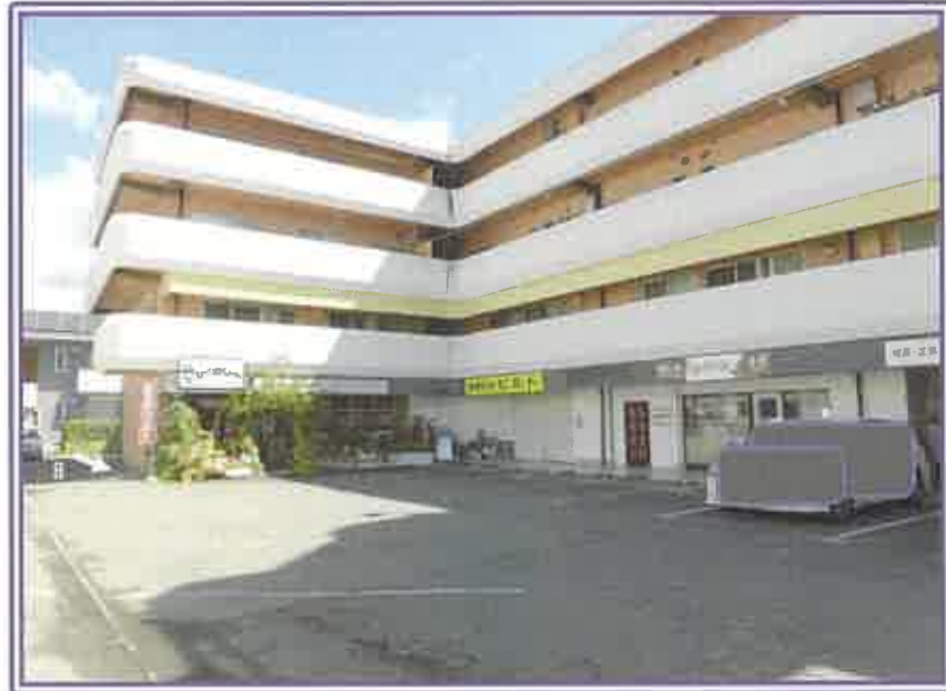
本件物件の正面側近景（手前は1階店舗用の共用駐車場）
