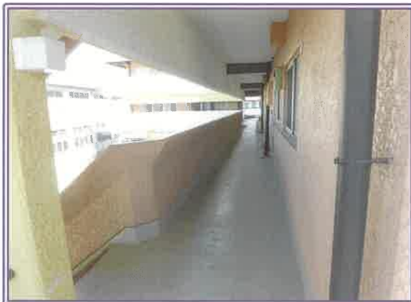
玄関通路（道路側）
