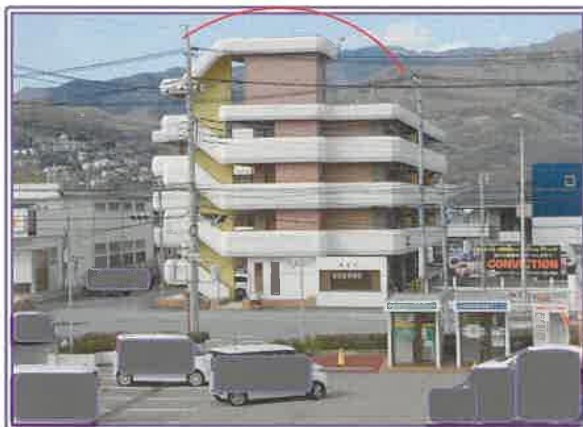
本件物件の道路側全景
