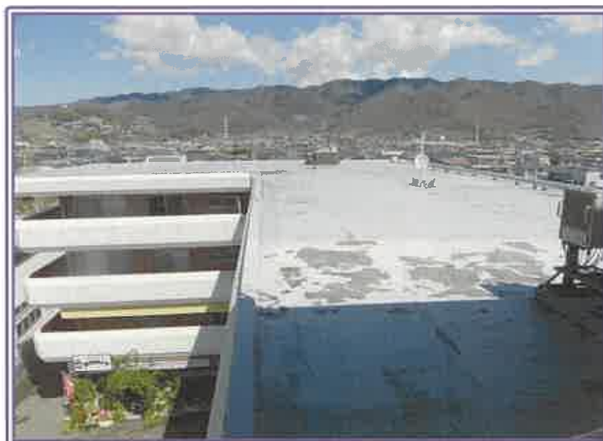
一棟の建物の屋上
