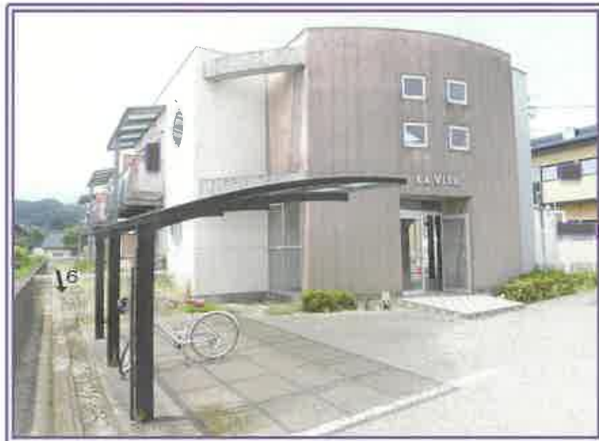
駐輪場（手前）と 本件建物の横側遠景
