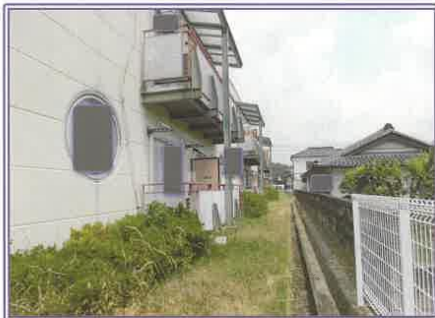
敷地内の状況
