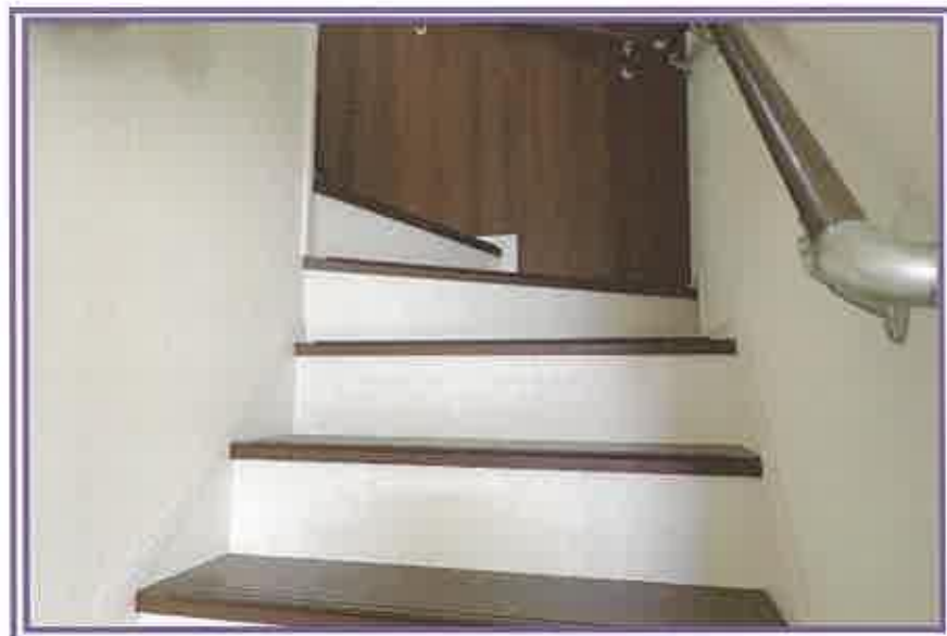
1階から、階段方向を撮影したもの(物件3)
