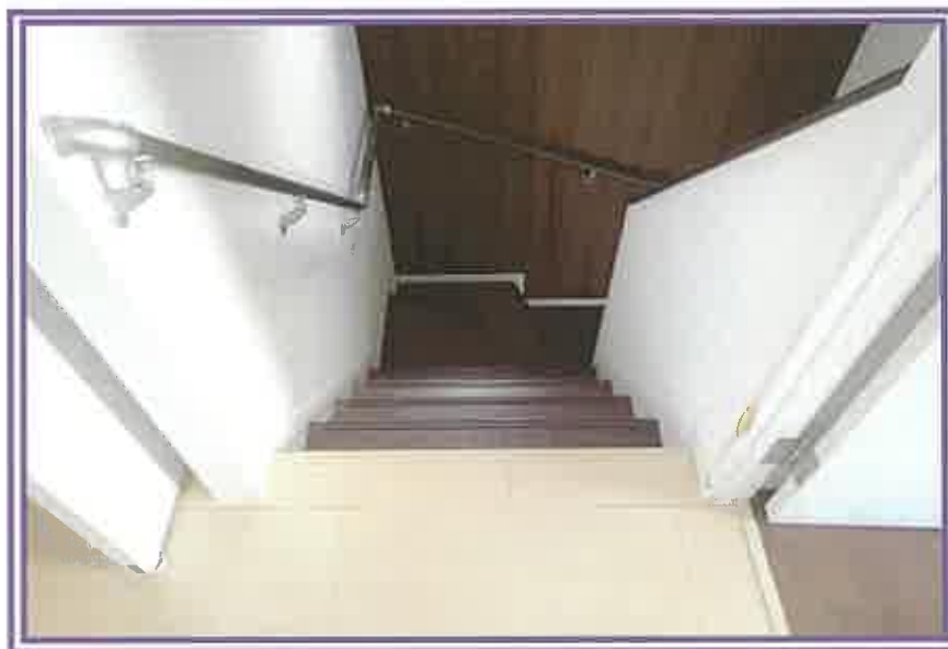
2階から、階段方向を撮影したもの(物件3)
