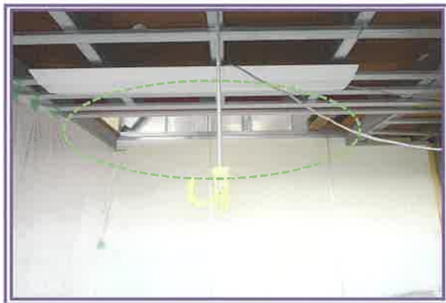
車庫内に設置されているロフト様の箇所への昇降口方向を撮影したもの(物件2)
