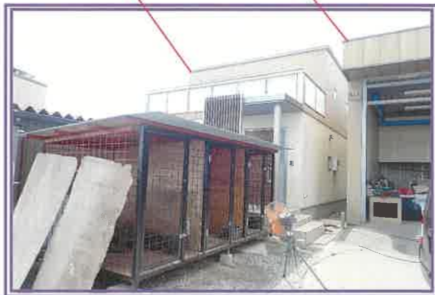
物件2(事務所, 車庫)
