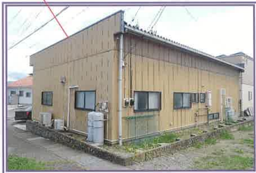
物件2(事務所, 車庫)
