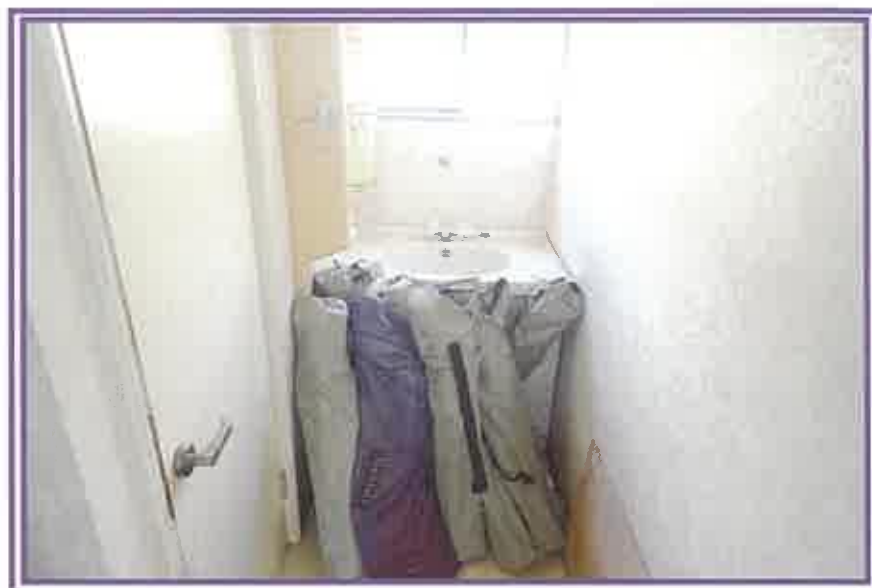
事務所のトイレ前に設置されている洗面台を撮影したもの(物件2)
