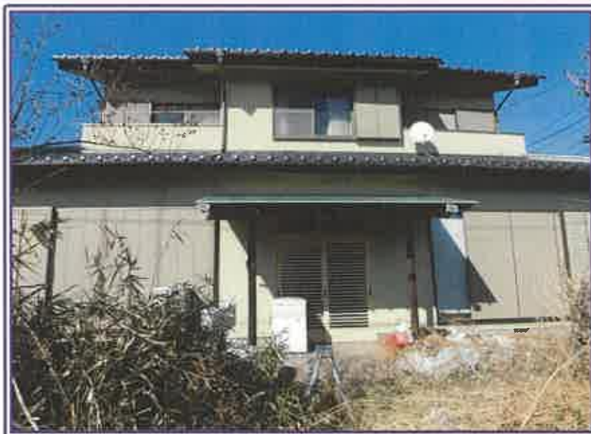
本件居宅の 正面近景
