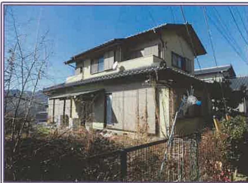
本件居宅の 南東側近景
