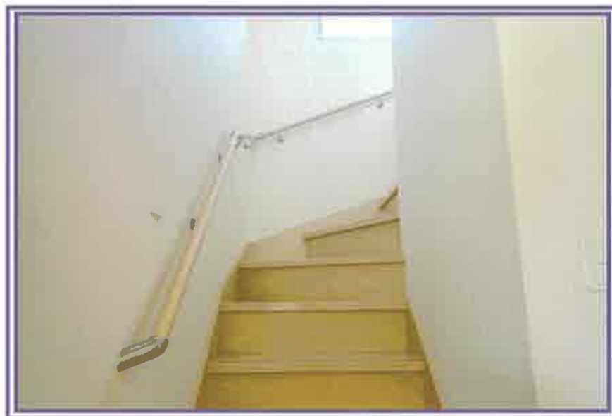
1階から、階段方向を撮影したもの
