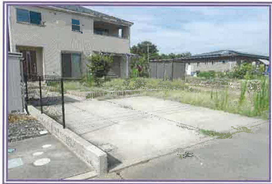
コンクリート敷の駐車スペース及びその周辺を撮影したもの
