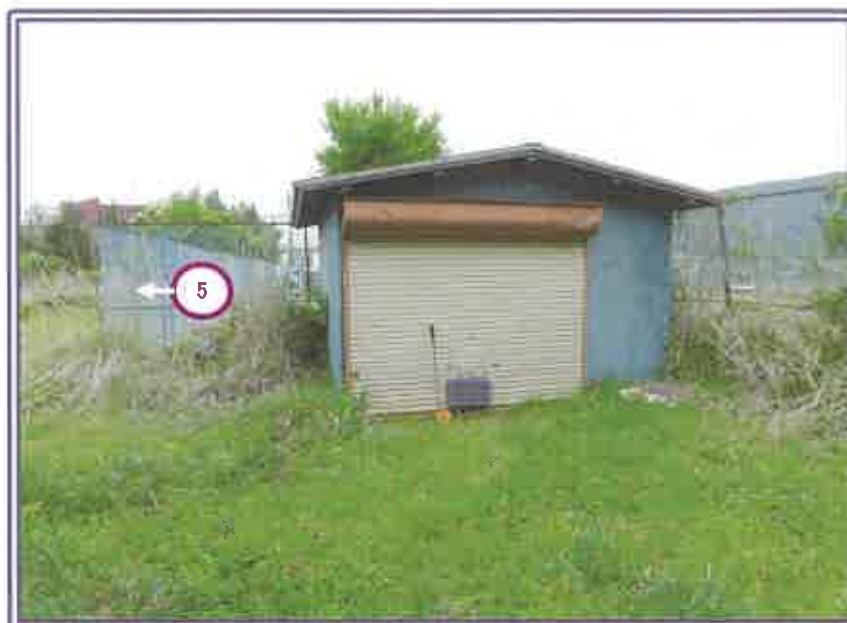
境界付近に存する物置（構築物） ※ 背後は テニスコートである 隣地（822）付近
