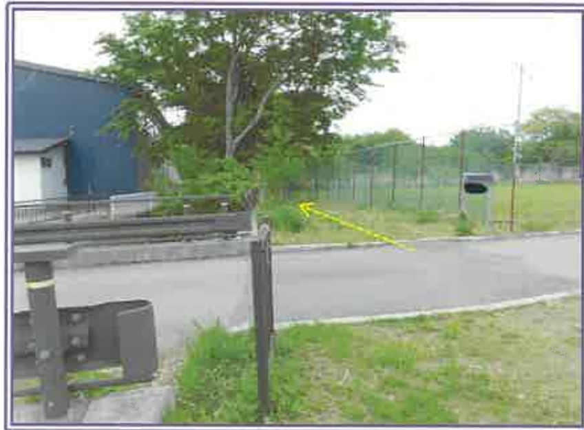
公道からの出入口の状況
