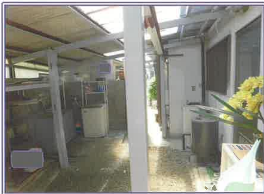
雨除（洗濯場所等）の状況
