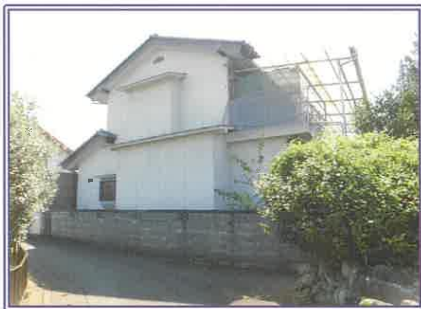
横（舗装道路）側近景
