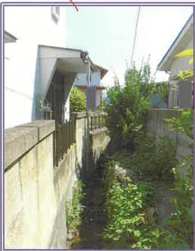
隣接水路の状況
