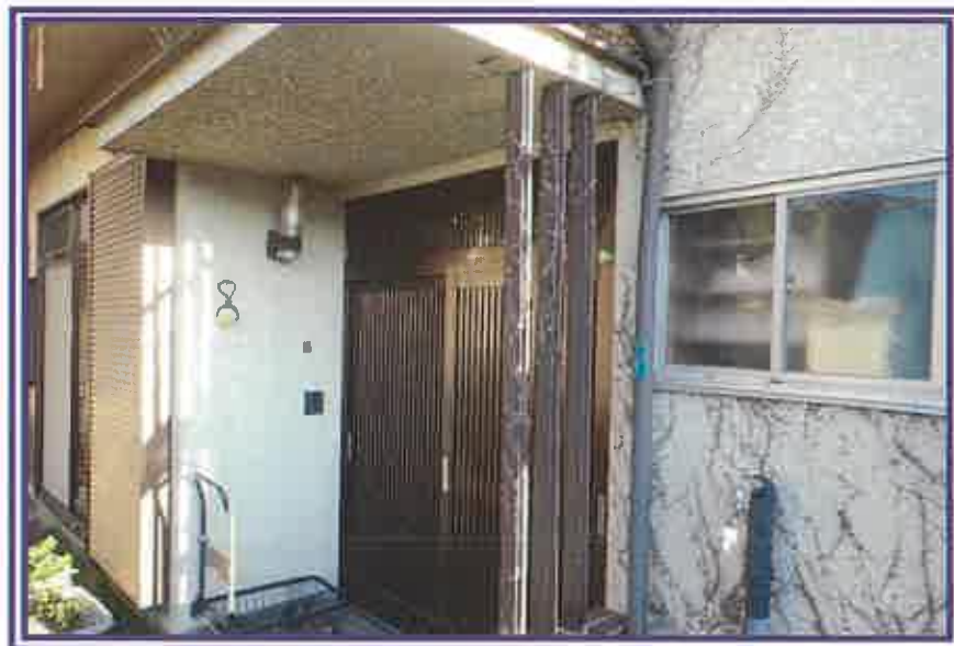
玄関付近を撮影したもの
