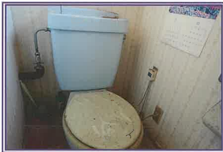
トイレ(西側増築部分の2階)
