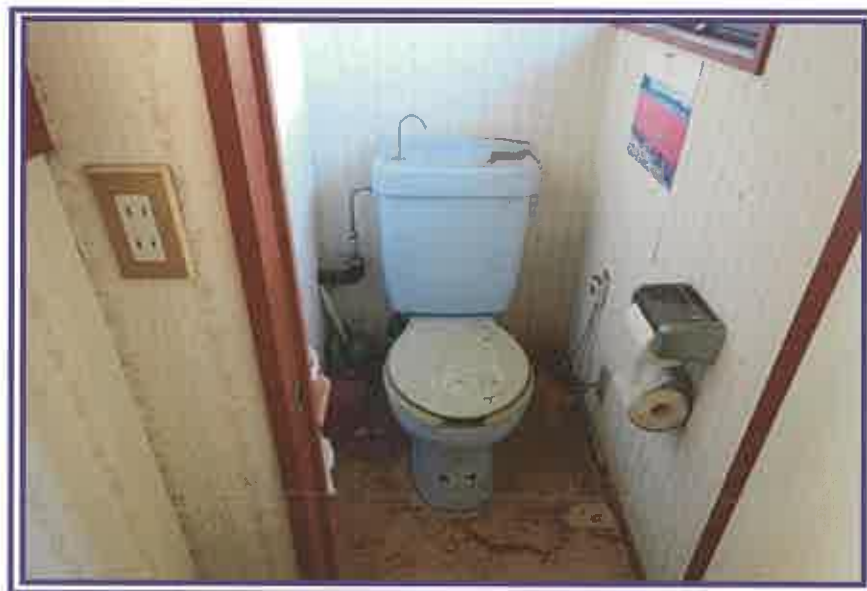
トイレ(西側増築部分の2階)
