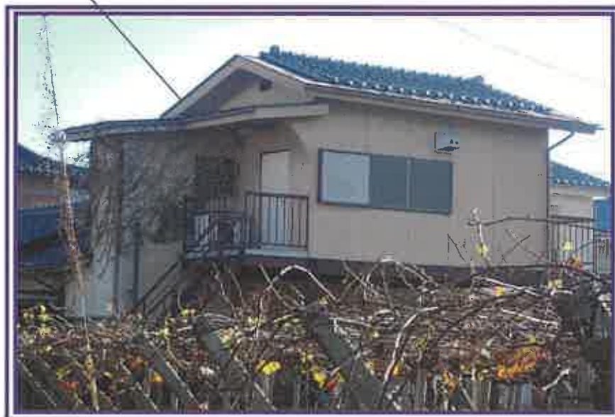
西側増築部分及びその周辺を撮影したもの(拡大撮影)
