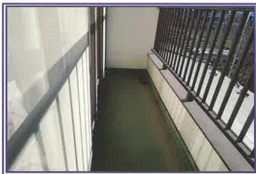
ベランダ(南側増築部分の2階)
