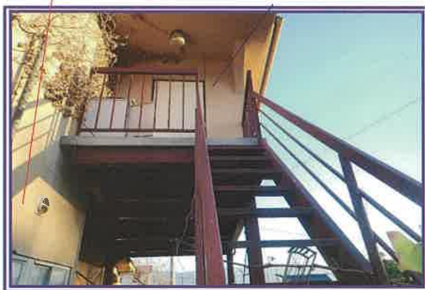
西側増築部分 (2階のみ増築)
