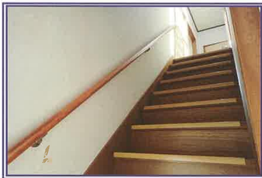
1階から階段方向を撮影したもの(南側増築部分)
