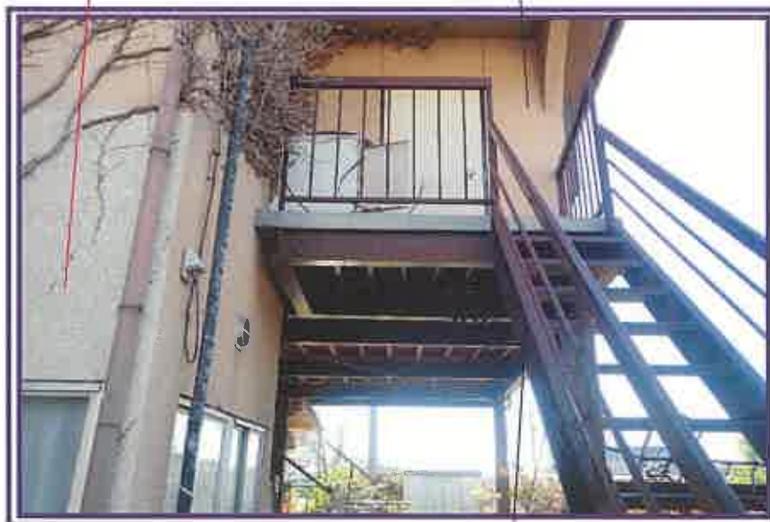
西側増築部分 (2階のみ増築)
