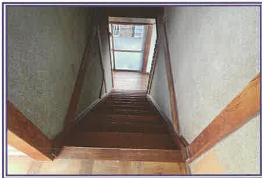
2階から階段方向を撮影したもの
