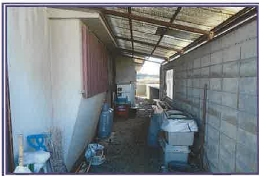
下屋内部を撮影したもの
