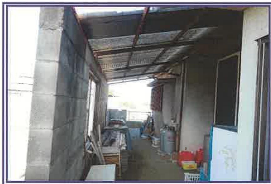
下屋内部を撮影したもの
