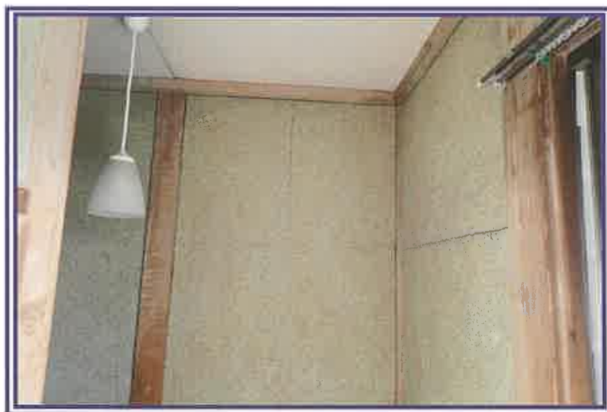
壁に損傷(亀裂)が認められる状況を撮影したもの(2階階段付近の廊下)
