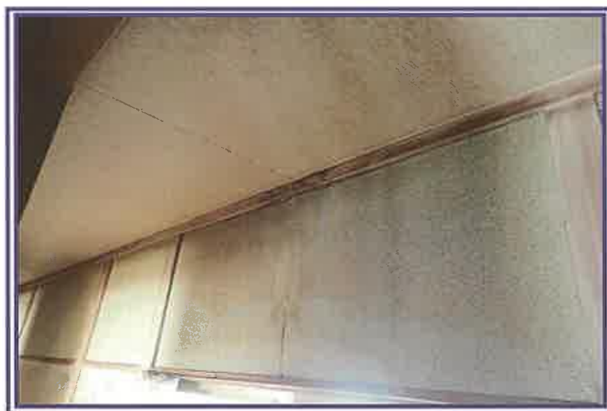
壁に損傷(亀裂)及び雨漏り跡が認められる状況を撮影したもの (1階階段付近の廊下)
