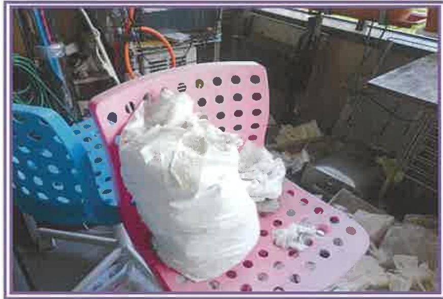
ベランダの状況を撮影したもの
