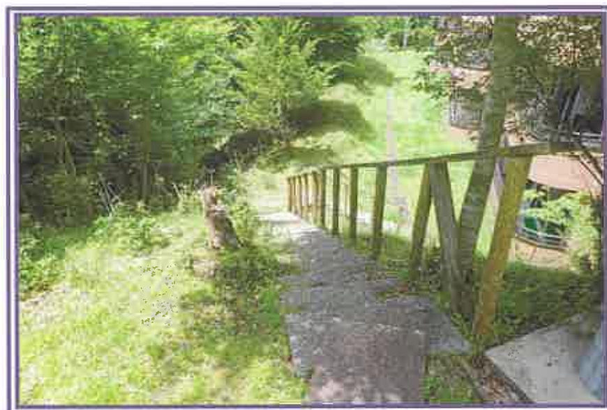
本物件敷地内に設置されている外階段及びその周辺を撮影したもの
