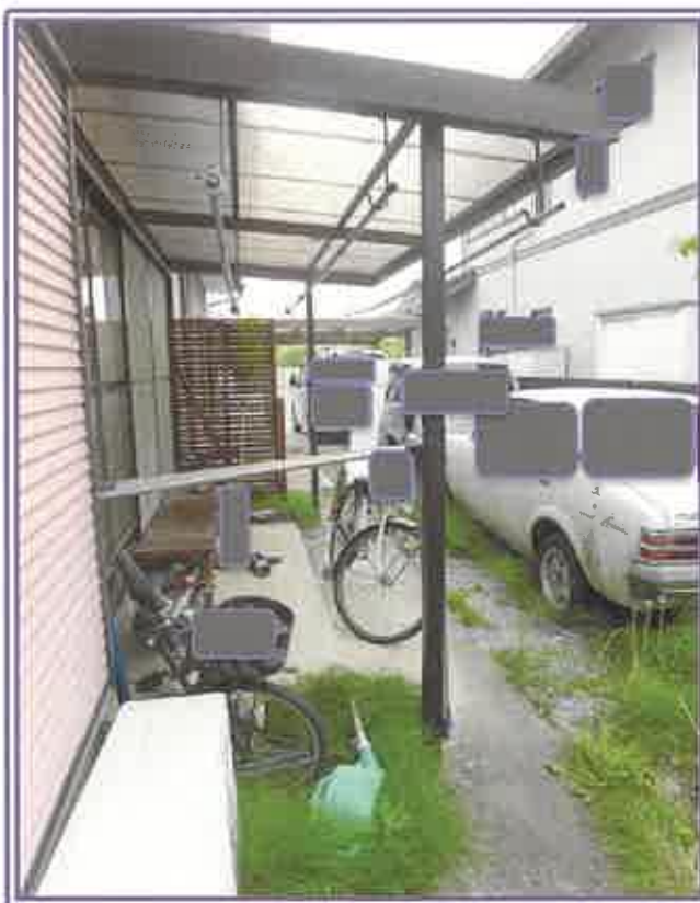
敷地内の状況
