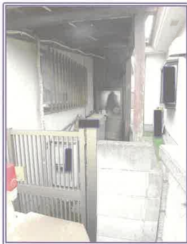
本件物件の南西角付近の状況 ※ 奥は物置（増築箇所）
