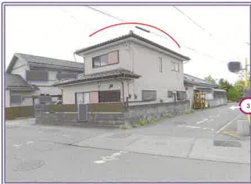
本件物件の交差点側全景
