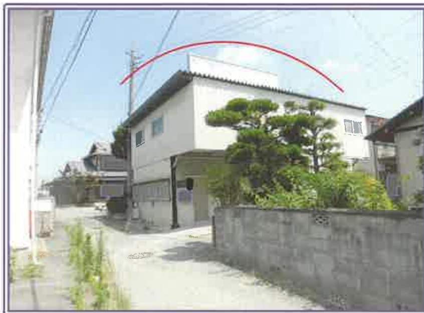
本件物件の道側全景
