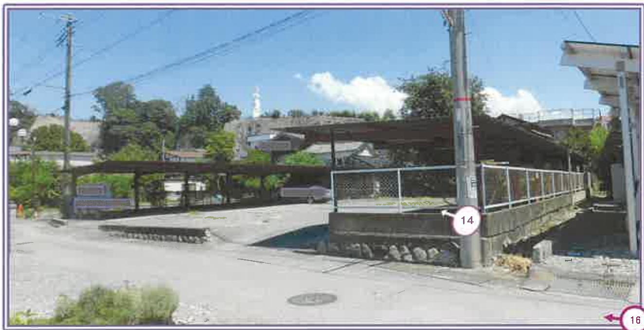
駐車場の全景
