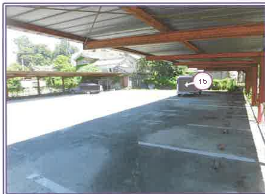
駐車場の状況
