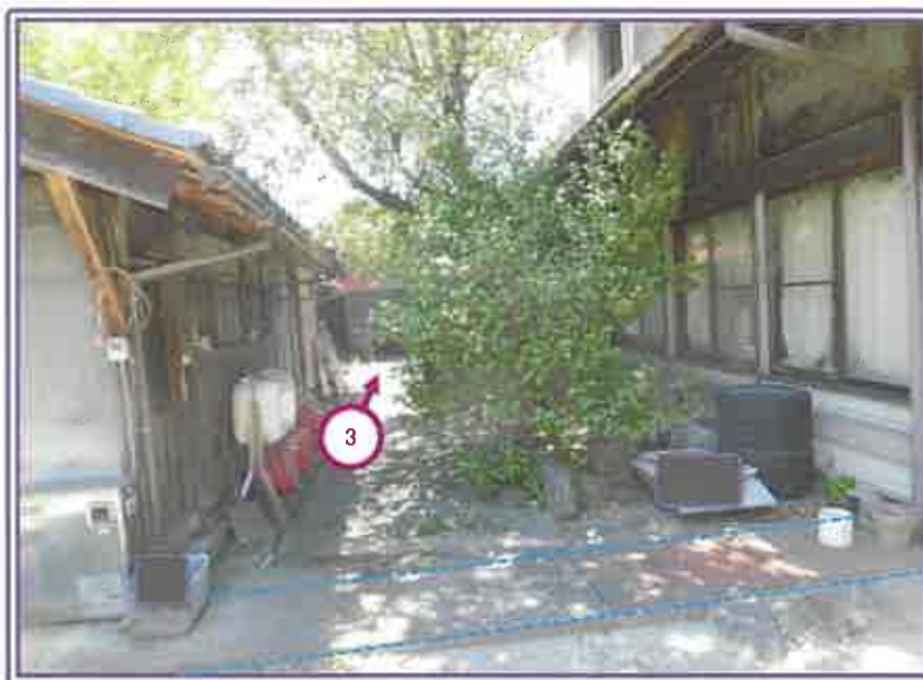
売却対象の（物件9の）両側の建物 ※ 手前の鉄板等の下に 水路が現存する
