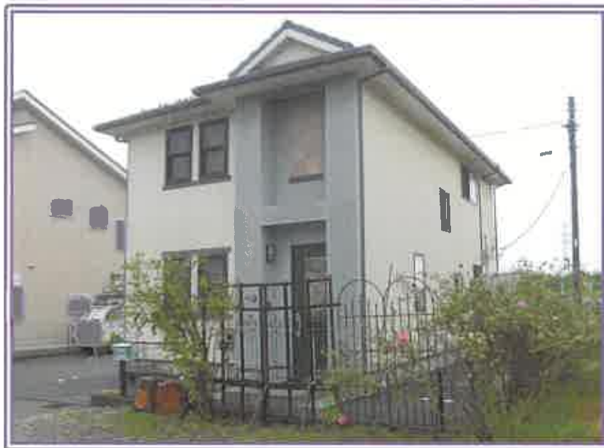
本件建物の裏側近景
