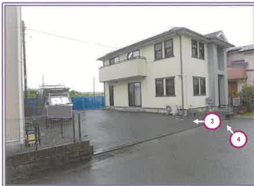
本件土地建物の全景
