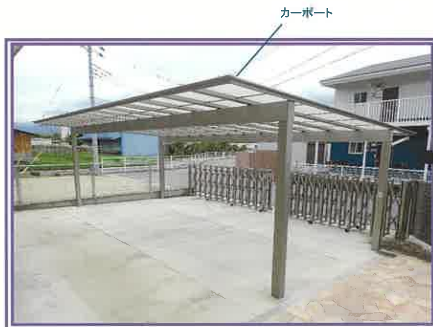
カーポート及びその周辺を撮影したもの
