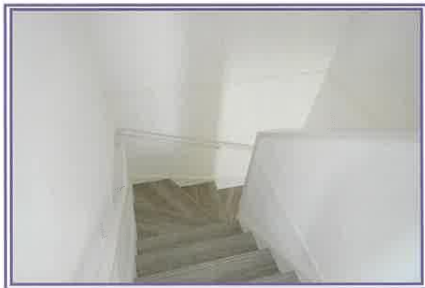
2階から、階段方向を撮影したもの
