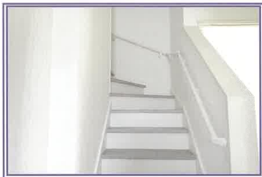
1階から、階段方向を撮影したもの
