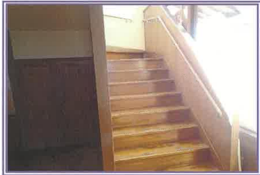
1階から、階段方向を撮影したもの
