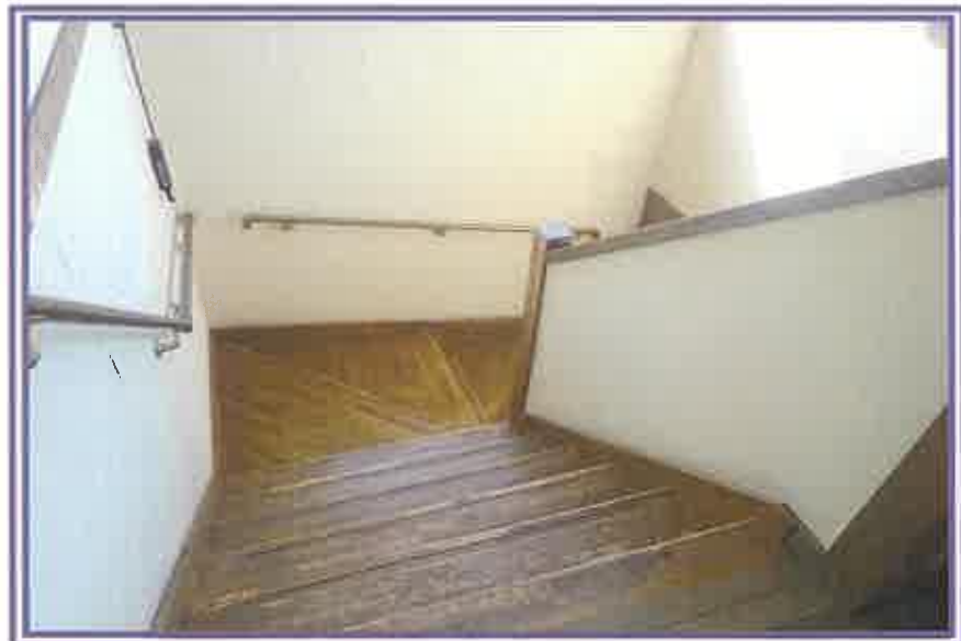
2階から、階段方向を撮影したもの
