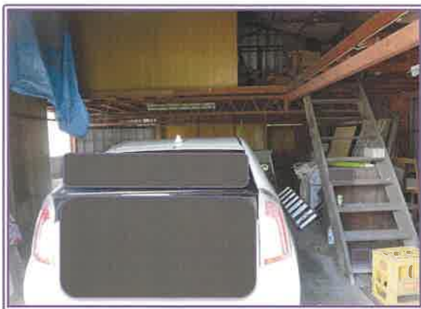
1階 車庫・2階 物置（物件5・附属建物）
