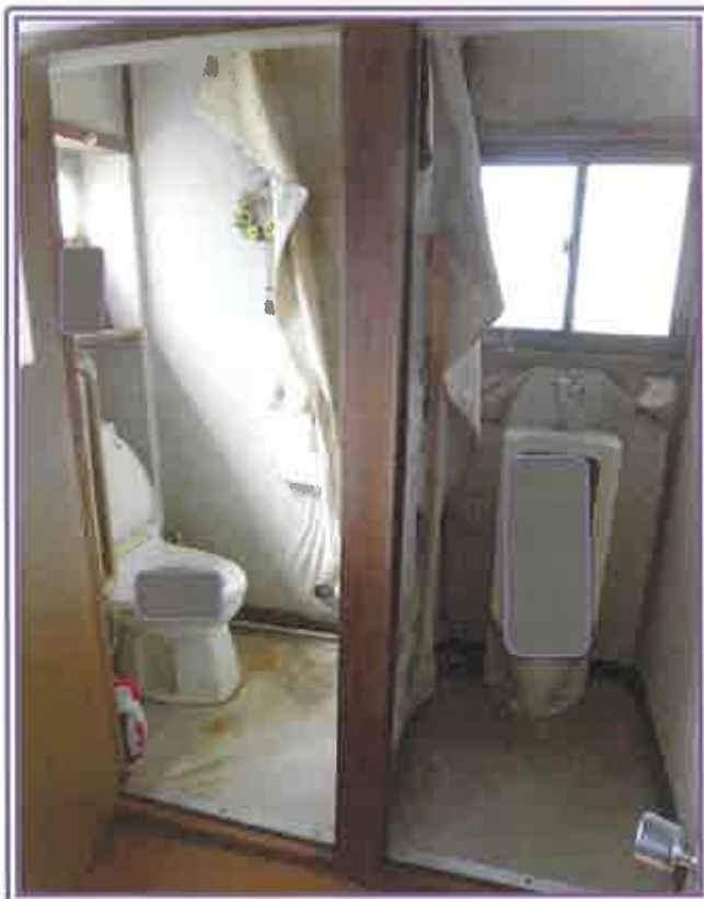
1階 トイレ（物件5・主たる建物）
