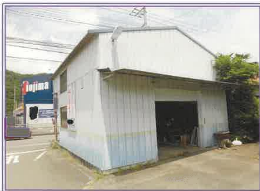
物件5・附属建物（車庫・物置）の近景
