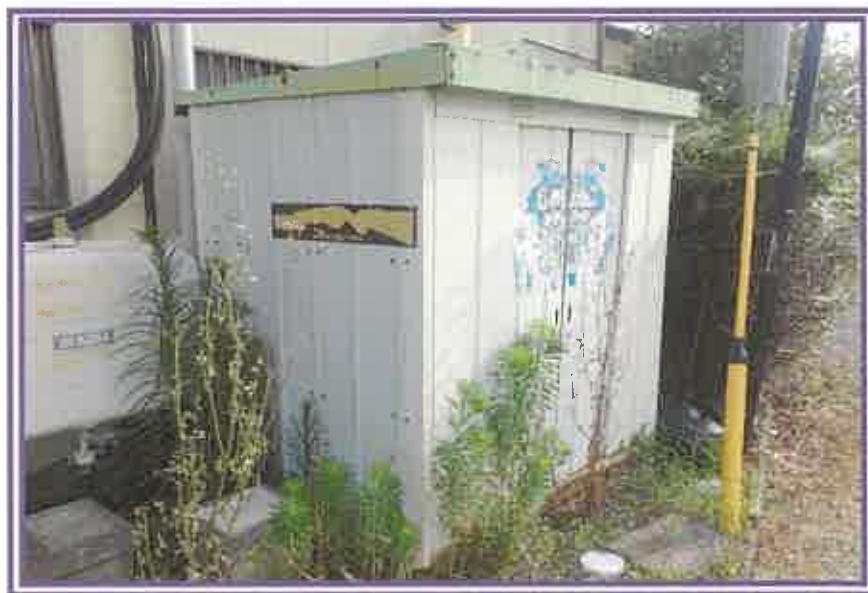
物置2及びその周辺を撮影したもの
