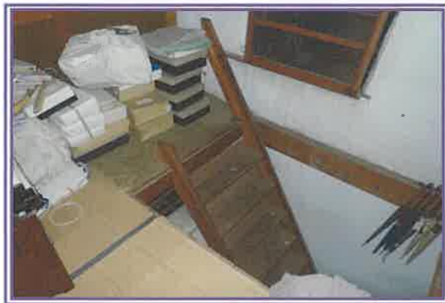
物件2附属建物符号1(物置)2階から、階段方向を撮影したもの
