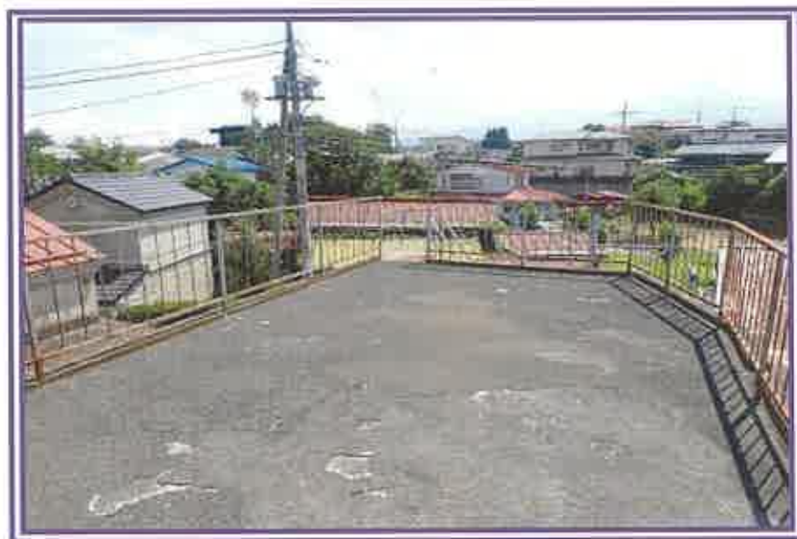
屋上(物件2附属建物符号2)
