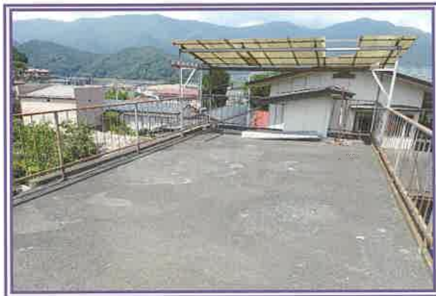
屋上(物件2附属建物符号2)
