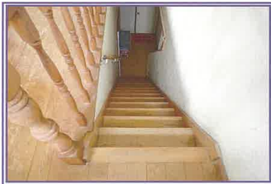
2階から、階段方向を撮影したもの
