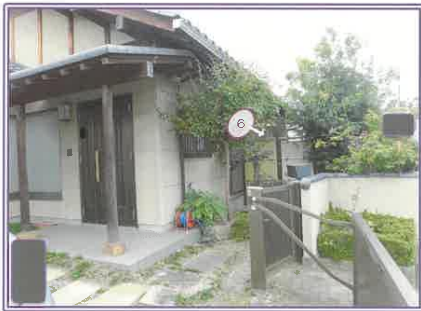
玄関ポーチ付近
